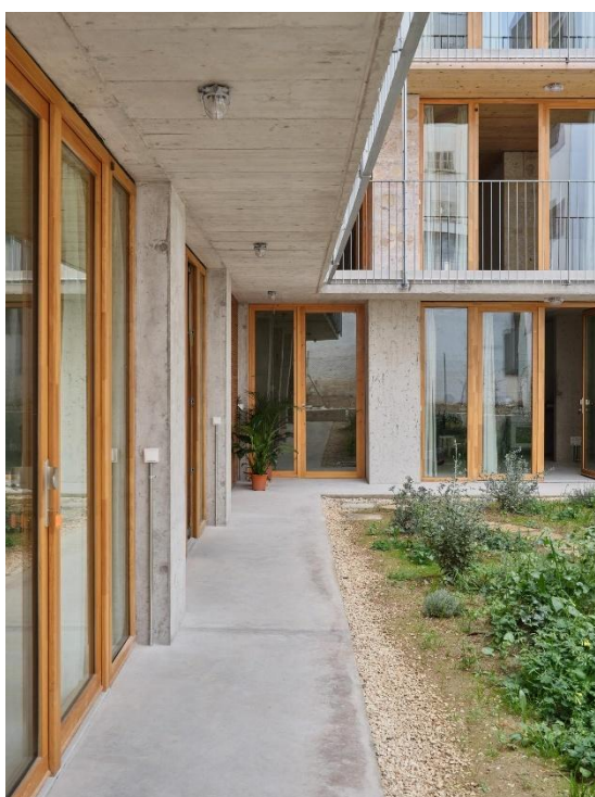
Figura 44 - Habitatge Socials , Vista Exterior do Piso Térreo
