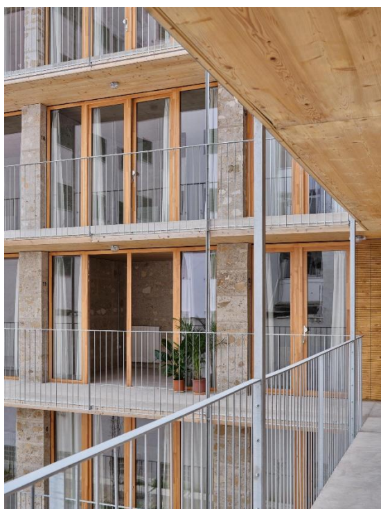
Figura 49 - Habitatges Sociais , Vista das Galerias de Acesso aos Apartamentos, Estrutura do Edifício
