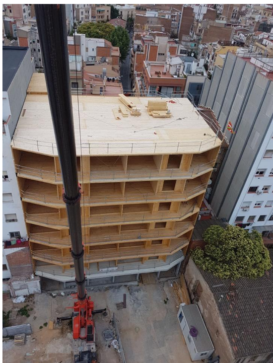
Figura 19 - La Borda , Edifício em Construção
