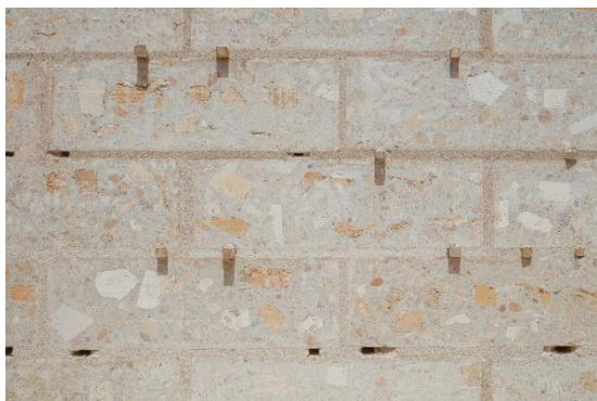
Figura 47 - Habitatges Sociais , Textura da Parede de Blocos de Betão
