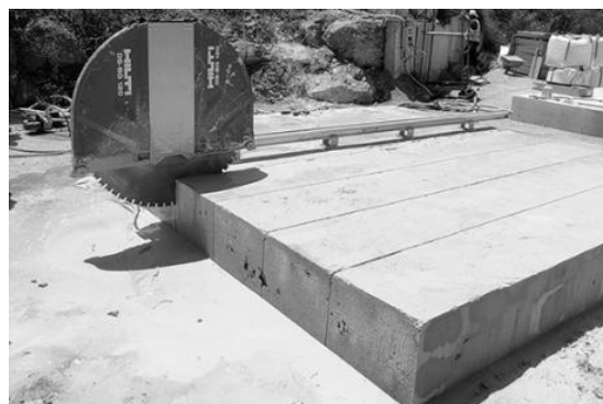
Figura 43 - Habitatge Socials , Corte dos Blocos de Betão Ciclópico
