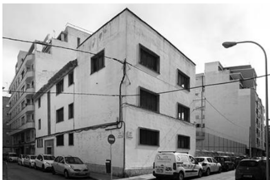
Figura 42 - Habitatge Socials , Edifício Antigo
