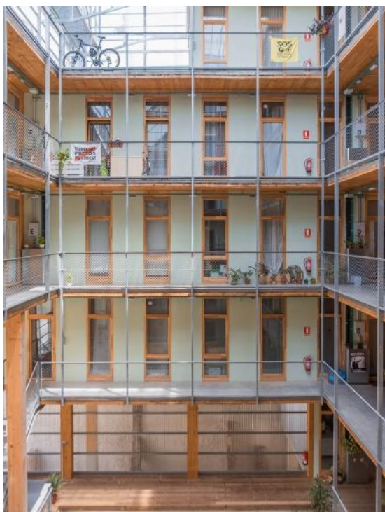
Figura 21 - La Borda , Galerias de Acesso aos Apartamentos
