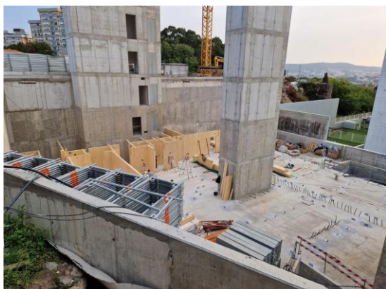
Figura 34 - The Log Porto Hotel , Estrutura em Betão e Início da Colocação dos Painéis CLT
