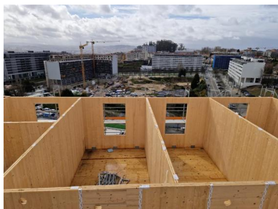
Figura 35 - The Log Porto Hotel , Montagem Modular dos Quartos
