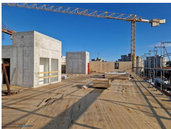
Figura 38 - The Log Porto Hotel , Montagem das Lajes dos Pisos
