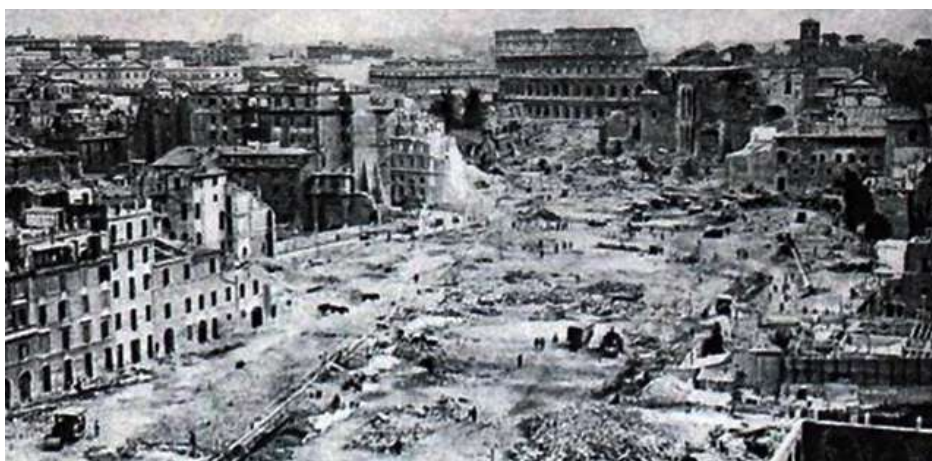
Figura. 21- Destruição causada pela abertura da Via dei Fori Imperiali. Fonte: Rome on Rome (2015)
