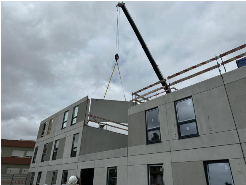
Fig. 16 Solução de construção industrializada em fachada com caixilhos (sistema CREE)
