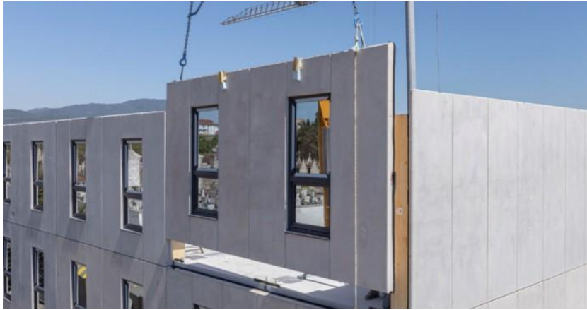
Fig. 16 Solução de construção industrializada em fachada com caixilhos (sistema CREE)
