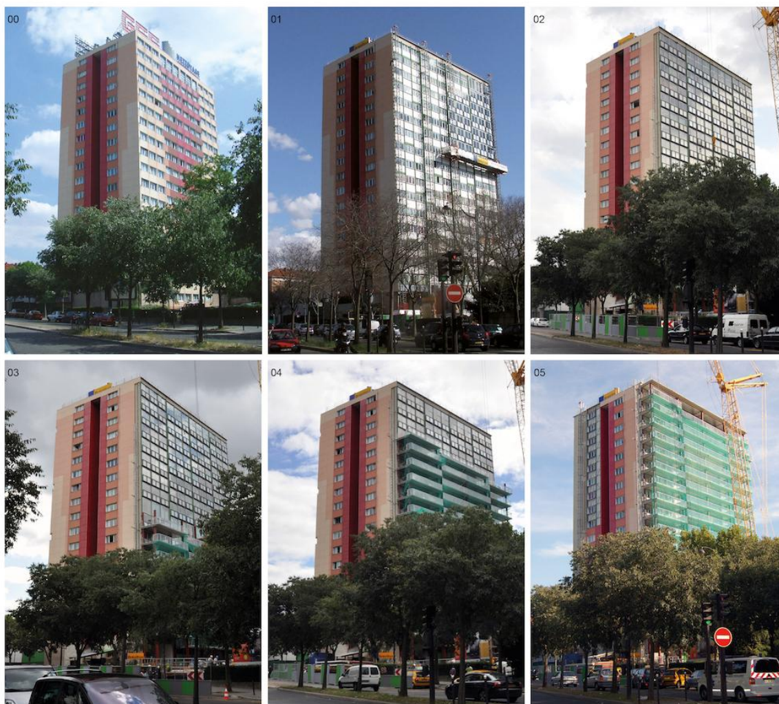
Fig. 17 Transformação da Torre Bois le Prêtre, Paris, por Druot, Lacaton & Vassal. Estrutura autoportante adicionada na periferia do edifício para ampliar apartamentos e criar terraços, mantendo os residentes durante a obra.
