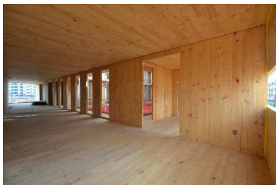
Fig. 35 Registo fotográfico da fase de construção da cooperativa La Borda, onde o uso da madeira e de estruturas pré-fabricadas (nomeadamente do núcleo das escadas) é visível.
