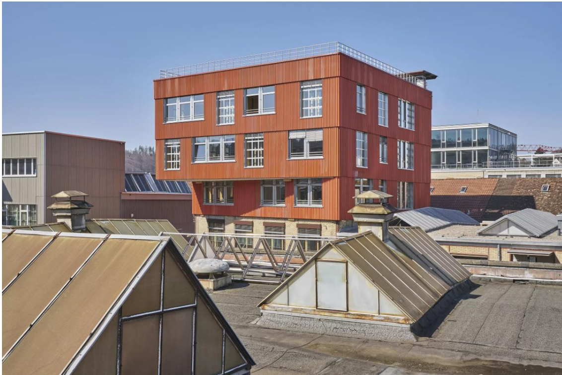
Figura 25 - Fotografia Exterior, K.118
