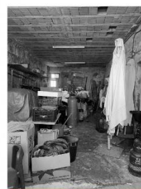
⑤ Laje aligeirada à vista
