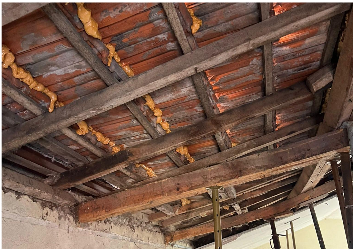
Figura 60 - Fotografia estrutura do telhado
