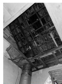
⑥ Estrutura do teto e cobertura
