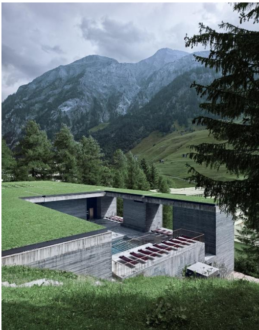
Figura 14 – Exterior das Termas de Vals de Peter Zumthor
