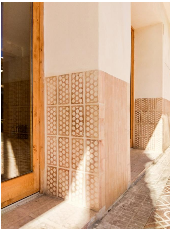
Figura 21 - Fotografias pormenores reuso, Can Picafort, TEd'A arquitectes
