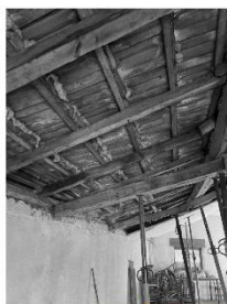
① Estrutura da cobertura
