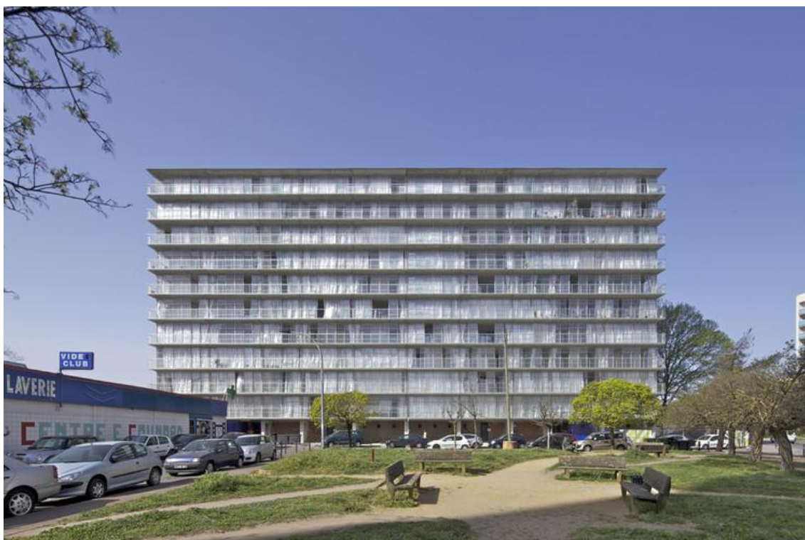
Figura 4 - Fotografia exterior da intervenção no Bairro Grand Parc
