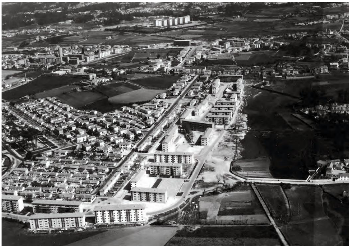
Figura 11 - Vista aérea do Bairro de Casas Económicas do Amial e do Bairro de Moradias Populares do Regado, Porto
