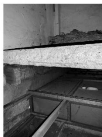
③ Laje do 1º Piso da casa
