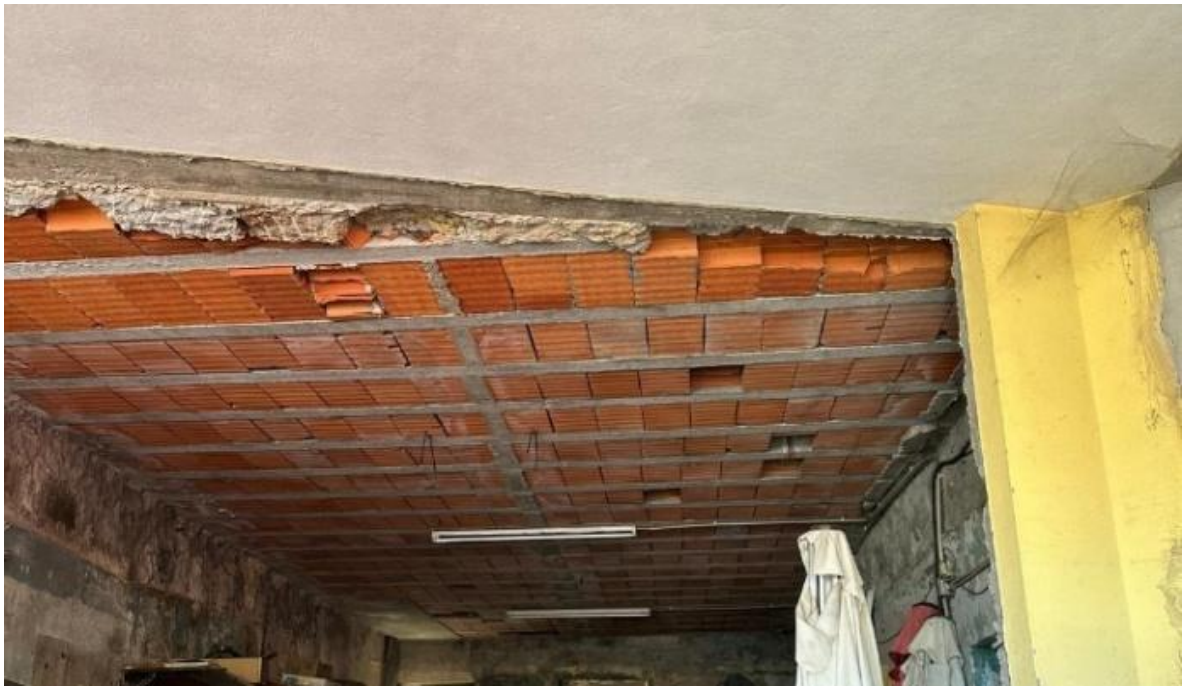
Figura 74- Laje de betão com abobadilhas cerâmicas à vista (2024).
