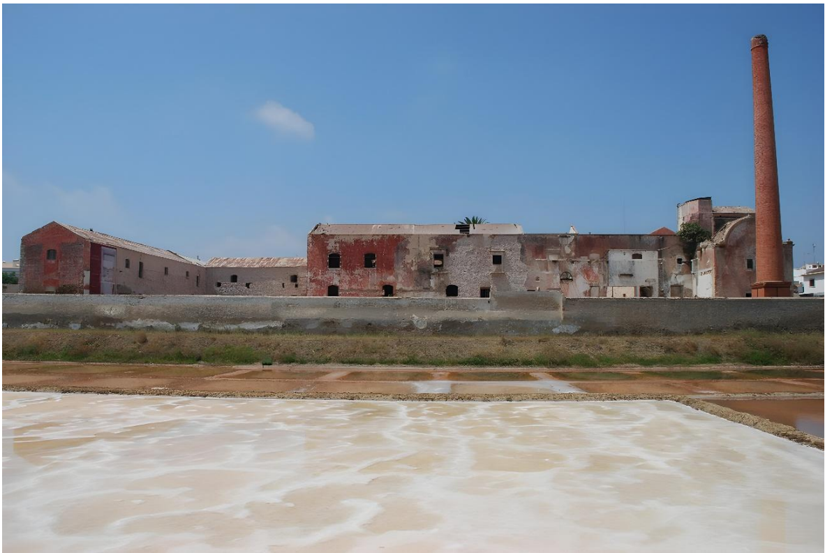
Figura 18- Vista geral do Convento das Bernardas antes da reabilitação, a partir da margem do rio Gilão, s.d.
