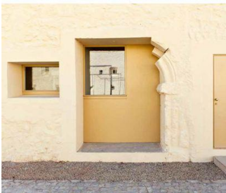
Figura 20- Convento das Bernardas, Tavira - abertura reconfigurada na fachada: fase de obra (em cima) e estado após a intervenção (em baixo), com preservação do perfil manuelino existente. s.d.
