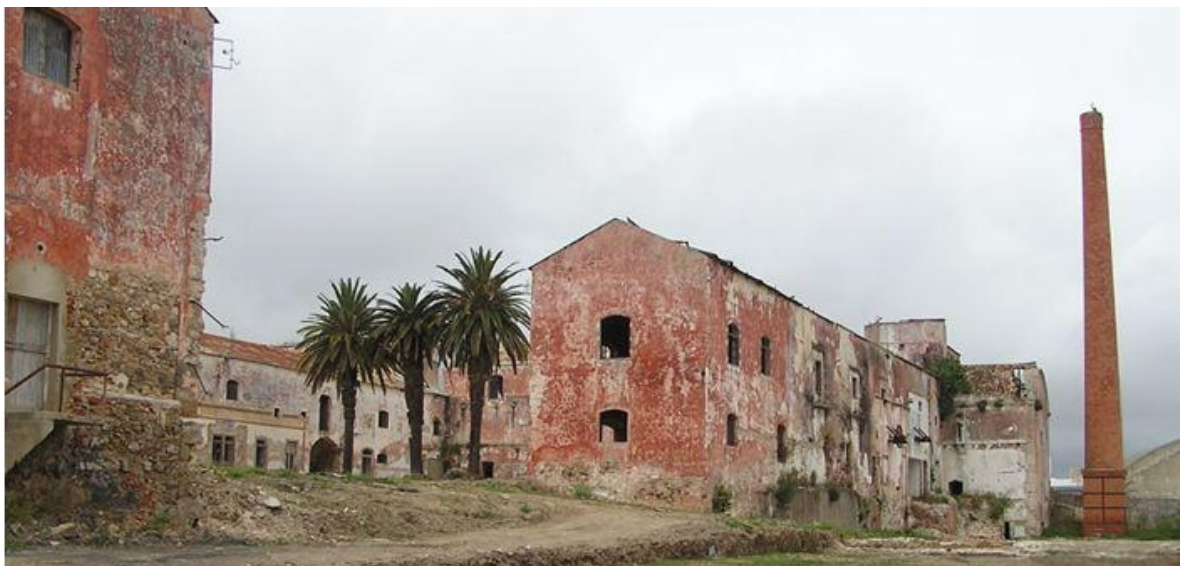
Figura 17- Fachada posterior do antigo Convento das Bernardas, voltada para o sapal e o rio Gilão, evidenciando o estado de ruína e a forte marca industrial prévia à intervenção de reabilitação. Ao centro, observam-se as fachadas com vãos irregulares resultantes da adaptação para moagem. À direita, a chaminé em tijolo é testemunho da fase industrial do conjunto, s.d.
