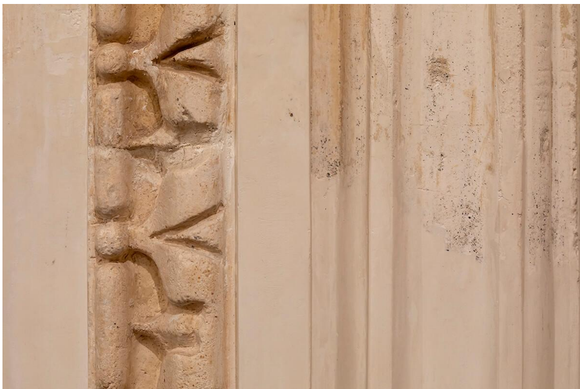
Figura 40- Detalhe do restauro minucioso dos elementos decorativos originais em estuque, evidenciando o cuidado técnico e o rigor material na recuperação das texturas e cores originais do Palácio Pereira, s.d.
