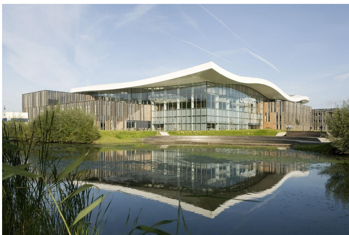
Figura 11- Alliander; Duiven - vista exterior do conjunto após a reconversão, com nova cobertura e fachadas em madeira reaproveitada, 2015.
