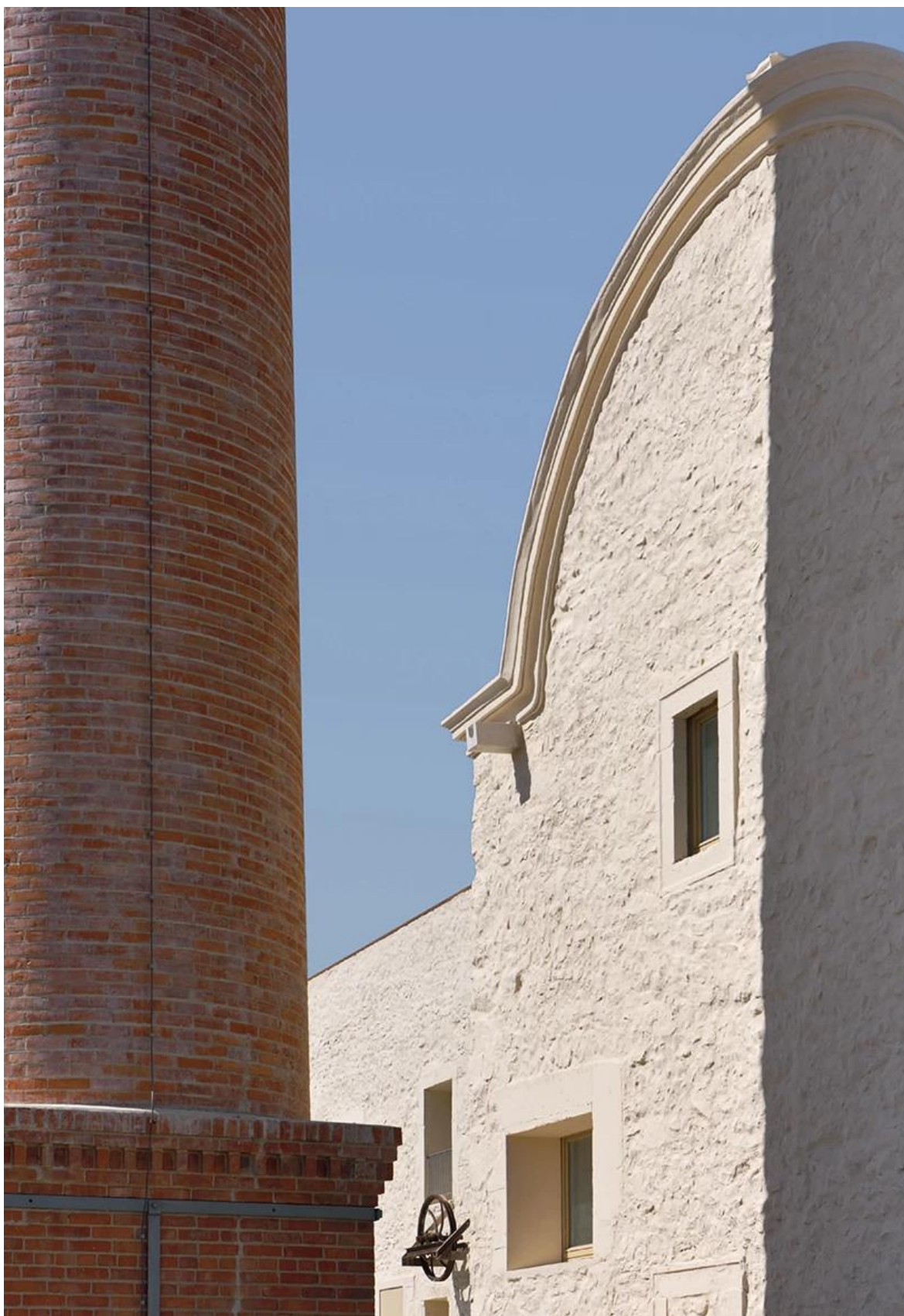
Figura 25- Convento das Bernardas, Tavira - chaminé em tijolo da antiga fábrica de moagem e massas (fase industrial) junto às fachadas reabilitadas do conjunto conventual, 2013.
