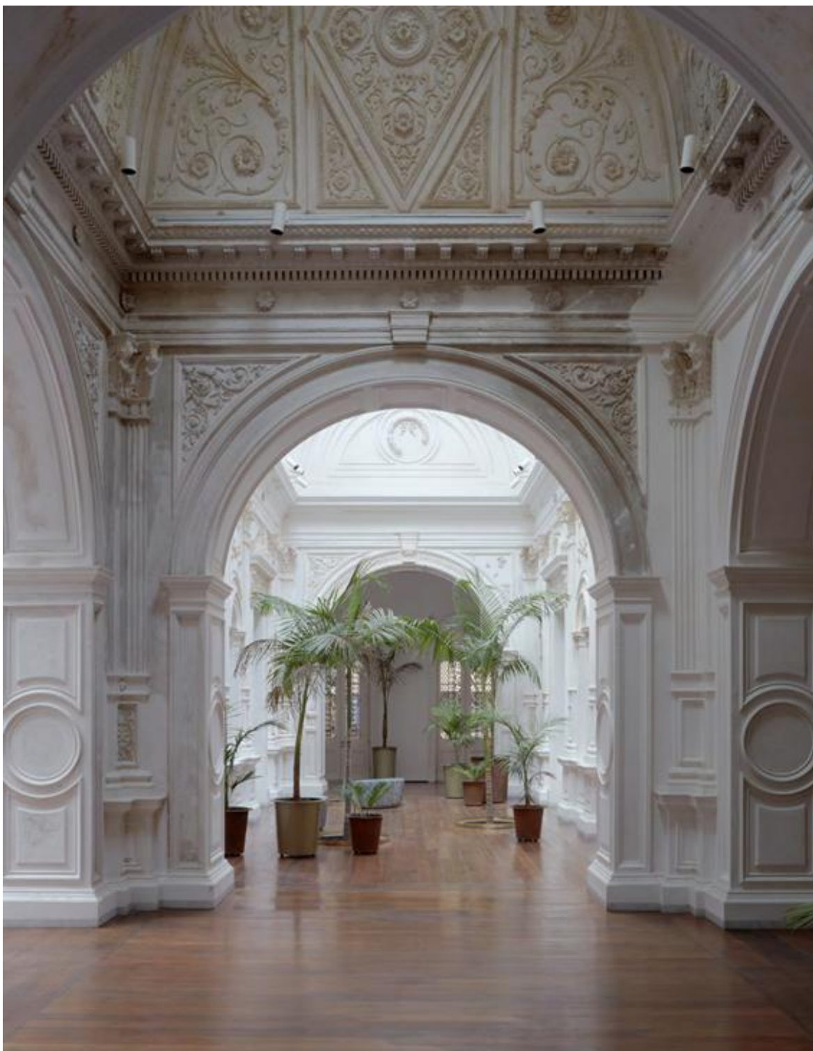
Figura 34- Interior do Palácio Pereira após intervenção, mostrando o restauro minucioso dos estuques e revestimentos originais, agora recuperados, 2021.
