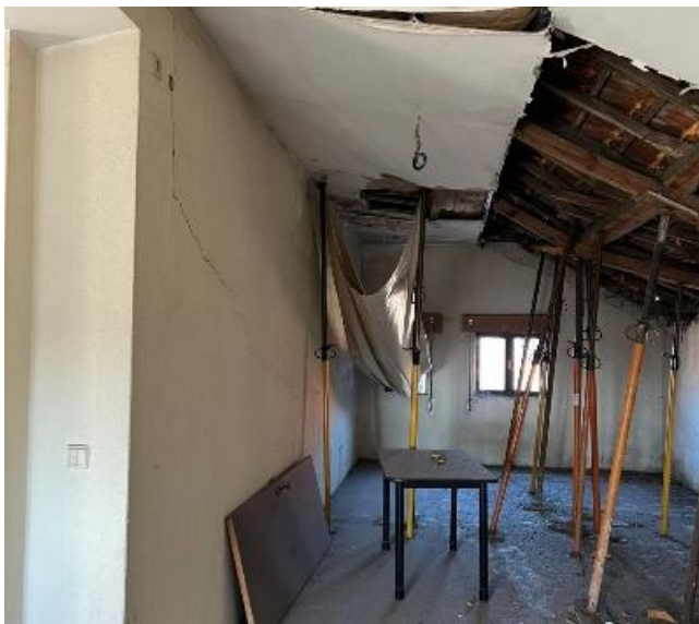
Figura 67- Cobertura com colapso parcial, mantida por escoramentos provisórios e lona de retenção; a fissuração de paredes e a deflexão do teto evidenciam risco de ruína iminente. (2024).
