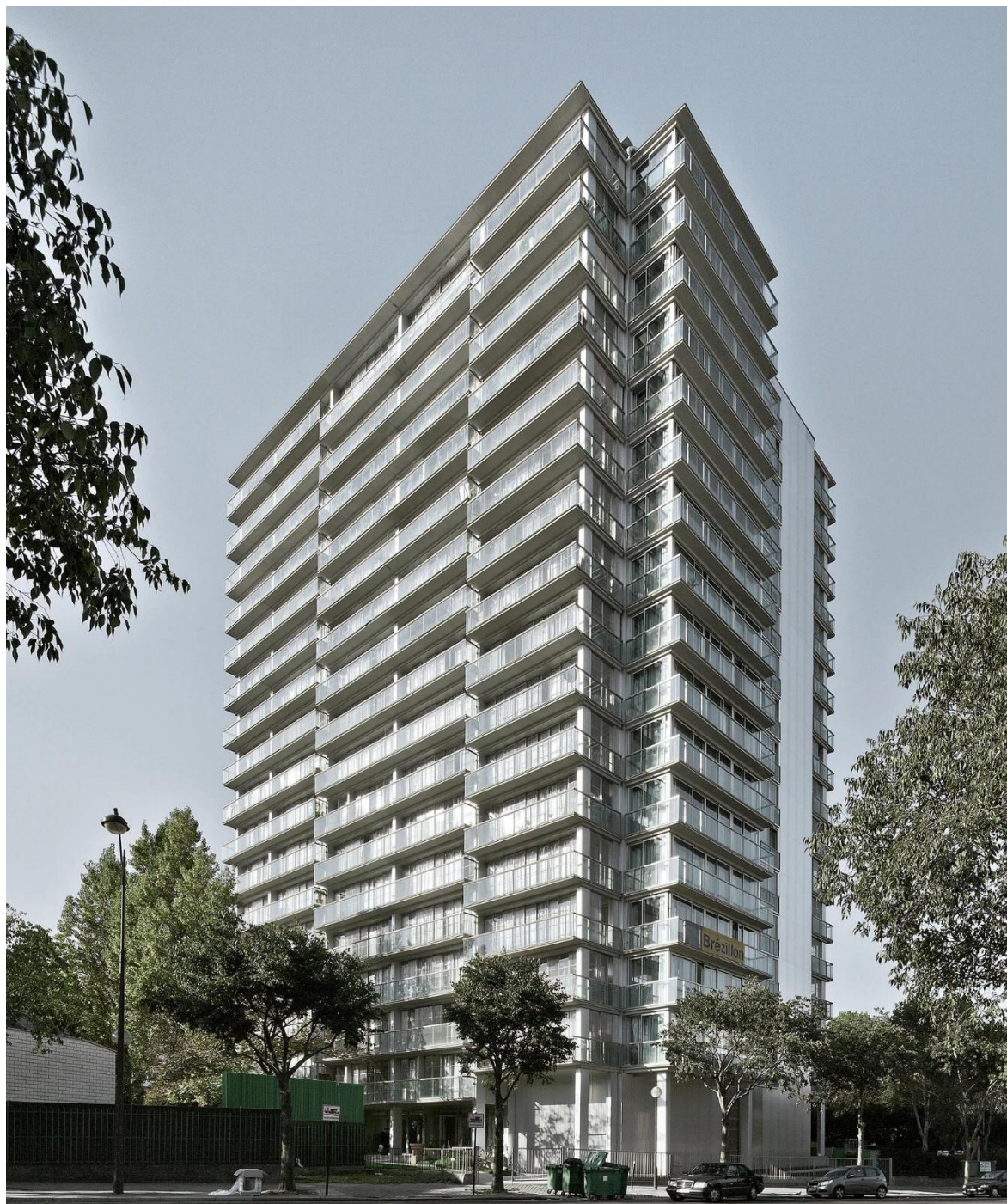
Figura 46- Vista exterior da Torre Bois-le-Prêtre após a intervenção, 2011.
