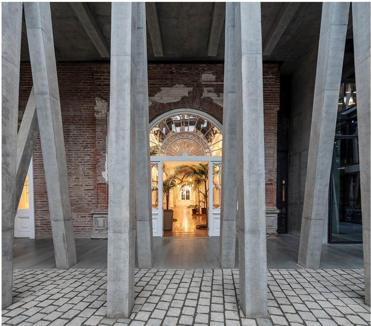
Figura 42- Vista do pátio interno do Palácio Pereira após a reabilitação, evidenciando a coexistência entre os novos elementos estruturais em betão aparente e os detalhes arquitetónicos originais, criando um diálogo visual e material entre o antigo e o contemporâneo, s.d.
