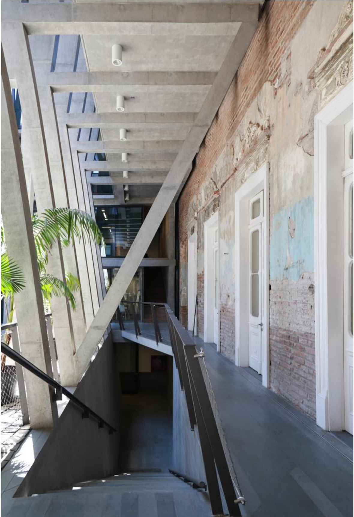
Figura 36- Circulação interna do Palácio Pereira, evidenciando o contraste entre a estrutura contemporânea em betão armado e os vestígios originais nas paredes, mantidos como testemunho da passagem do tempo, 2021.
