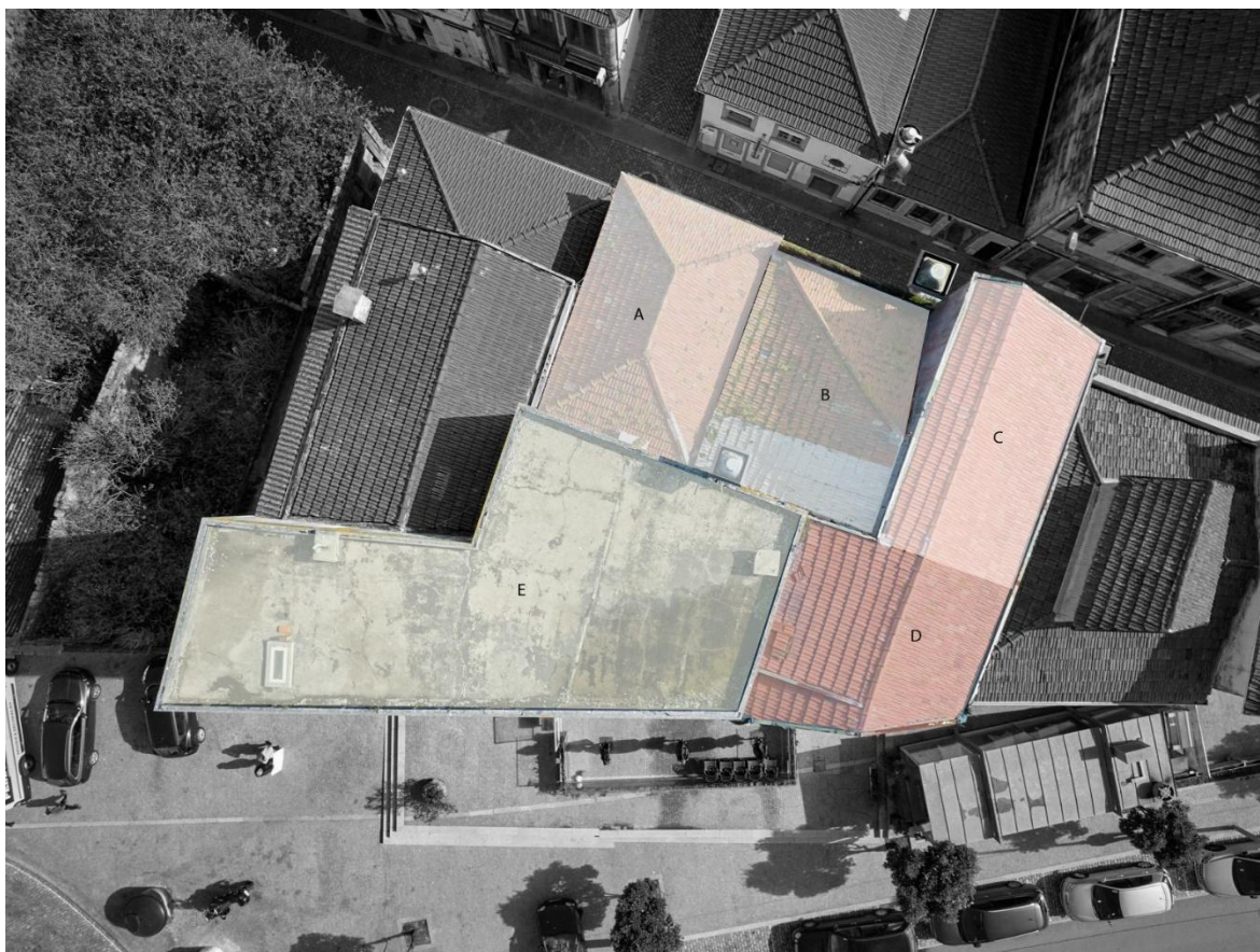
Figura 58- Vista aérea do conjunto - leitura cadastral, 2025.
