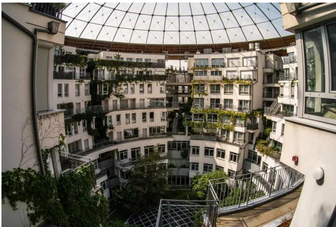
Figura 13- Gasómetros de Viena - pátio interior sob a cúpula envidraçada após a reconversão (1999–2001), com habitação e varandas ajardinadas organizadas em anéis concêntricos, s.d.
