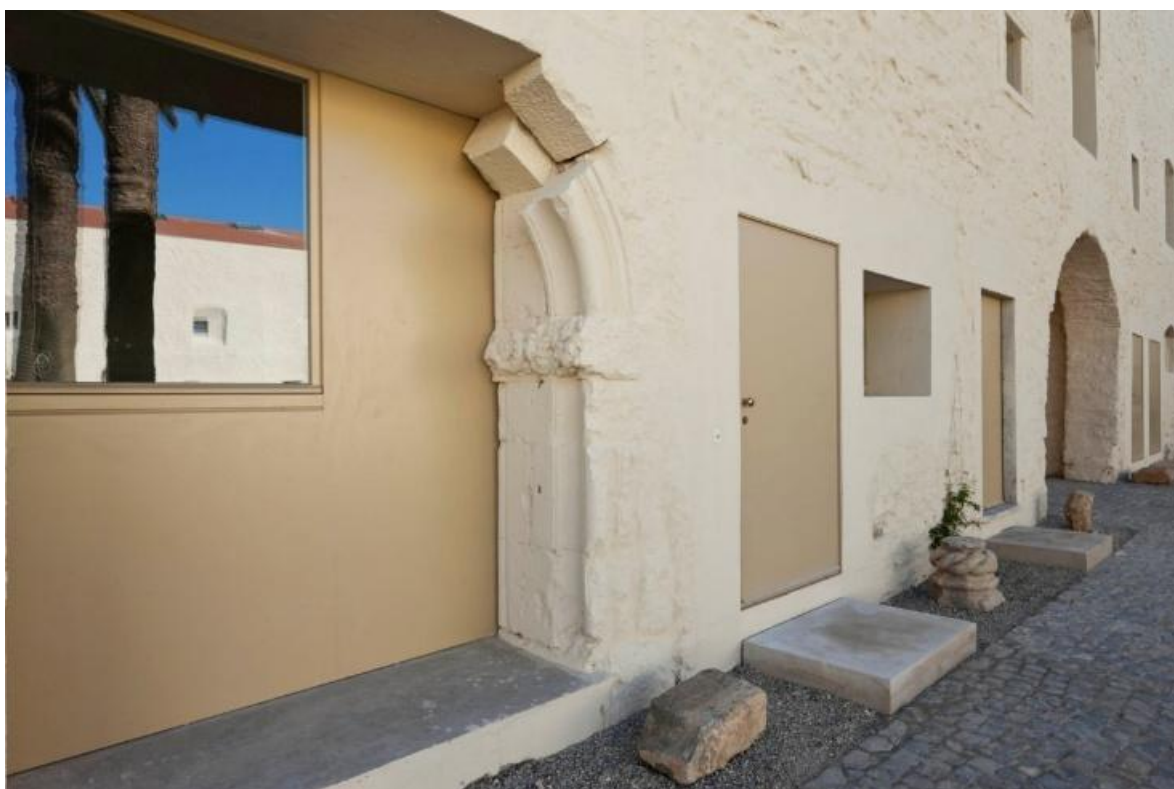
Figura 21- Convento das Bernardas, Tavira - frente poente com fragmento de arco manuelino integrado junto a novos vãos e caixilharias, mantendo distinção material e formal, 2011.
