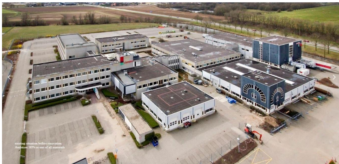
Figura 10- Alliander; Duiven - vista aérea do conjunto existente antes da intervenção. s.d.
