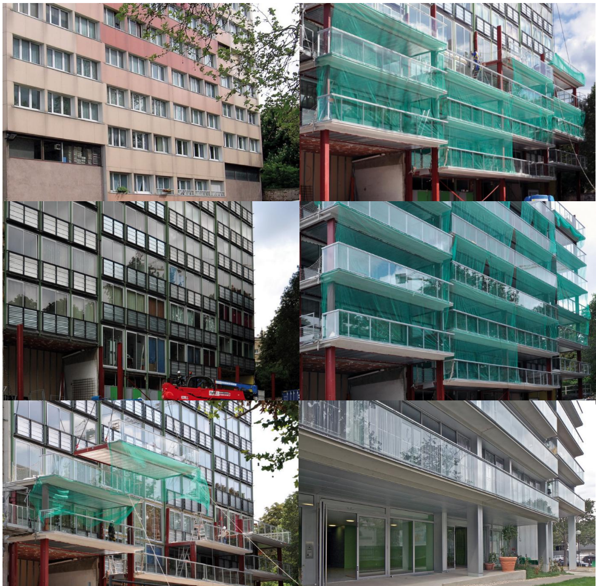
Figura 50-Sequência do processo de transformação da Torre Bois-le-Prêtre, em Paris. A imagem mostra a evolução da intervenção entre 2006 e 2011, destacando a remoção da fachada original (superior esquerda), a estrutura metálica para suporte das novas varandas e jardins de inverno (centro), e a instalação progressiva das superfícies envidraçadas translúcidas e dos espaços exteriores ampliados (inferior direita).
