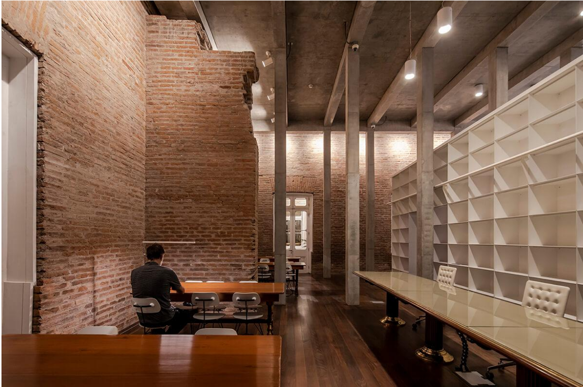
Figura 39- Espaço interior do Palácio Pereira após a intervenção, revelando a integração entre elementos estruturais contemporâneos em betão aparente e paredes originais de tijolo exposto, s.d.
