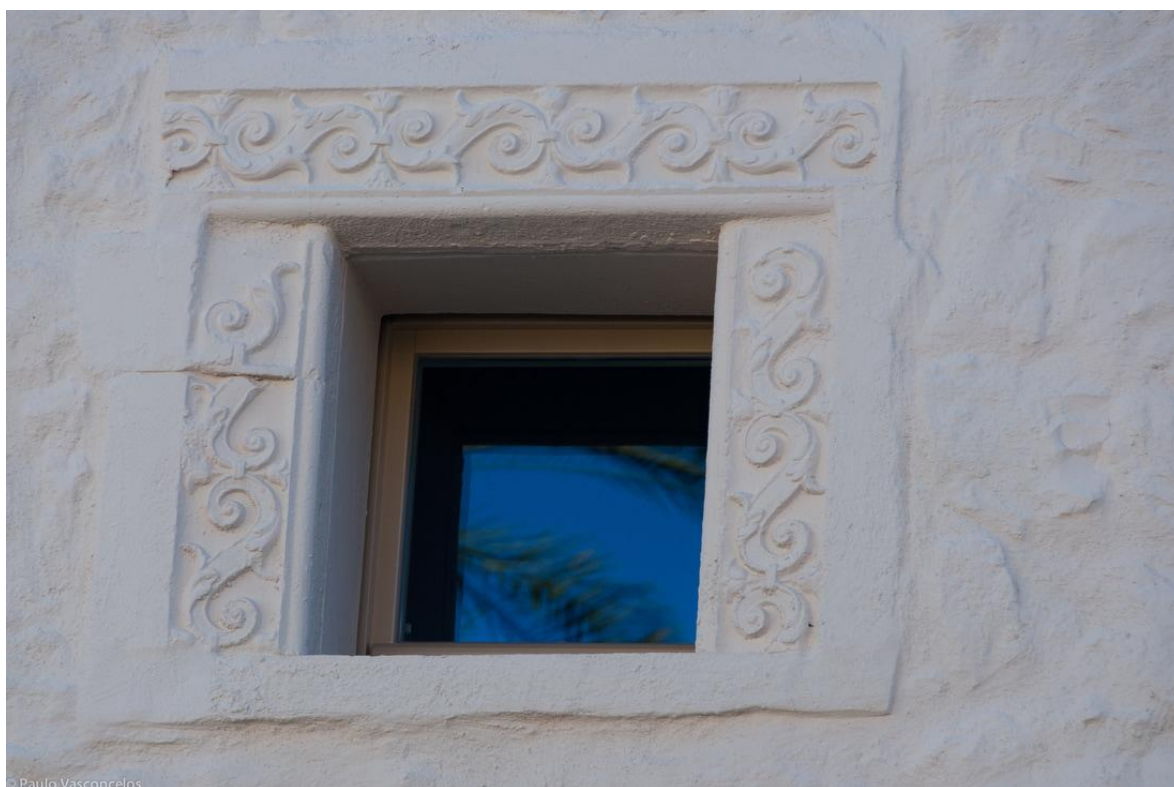
Figura 22- Convento das Bernardas, Tavira - detalhe de janela com caixilharia contemporânea inserida em moldura manuelina em cantaria, após reabilitação, 2013.
