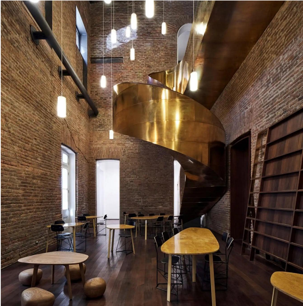
Figura 41- Palácio Pereira, Santiago do Chile - escada helicoidal em bronze convive com as paredes de tijolo originais do séc. XIX, evidenciando o diálogo entre novo e existente, s.d.
