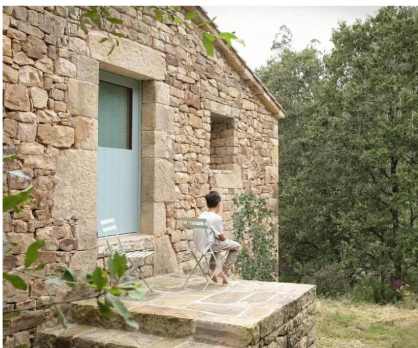
Fig. 42. Fachada em pedra (Fonte: Mínima)
