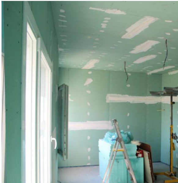
Fig. 32. Colocação das janelas e do isolamento (Fonte: Homegrid)
