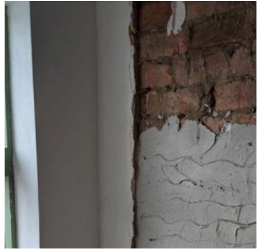
Fig. 16. Reboco de cal nas paredes interiores (Fonte: Passive House Plus )
