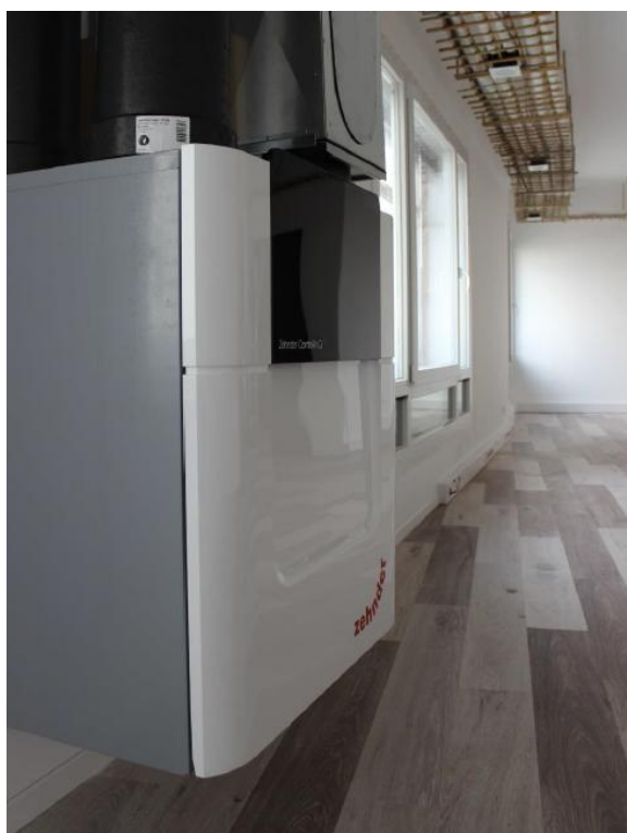
Fig. 35. Instalação da ventilação mecânica controlada (Fonte: Homegrid)
