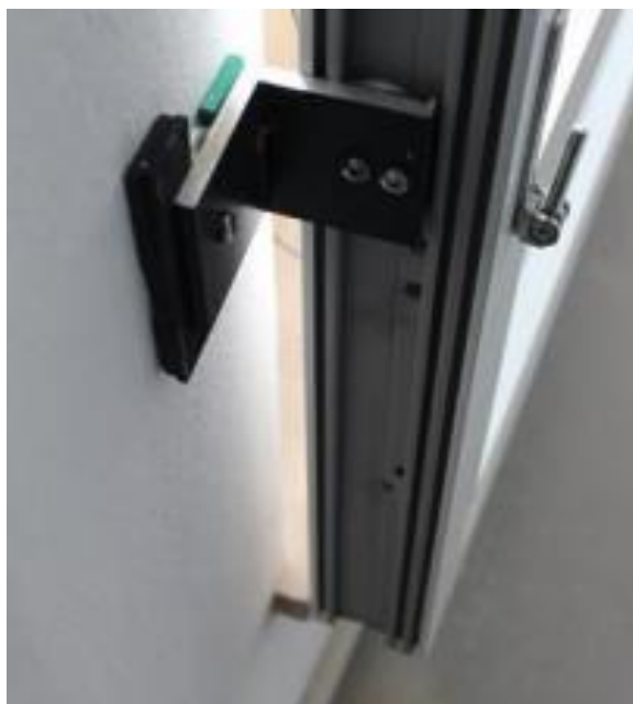
Fig. 34. Colocação das janelas antes da camada de isolamento (Fonte: Homegrid)
