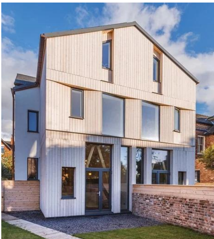
Fig. 12. Fachada Poente (Fonte: Guy Taylor Associates )
