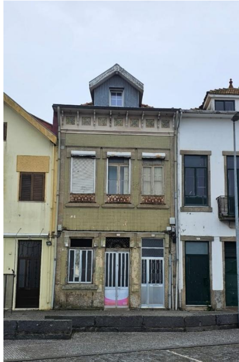
Fig. 55. Fachada Noroeste (Fonte: Autora)
