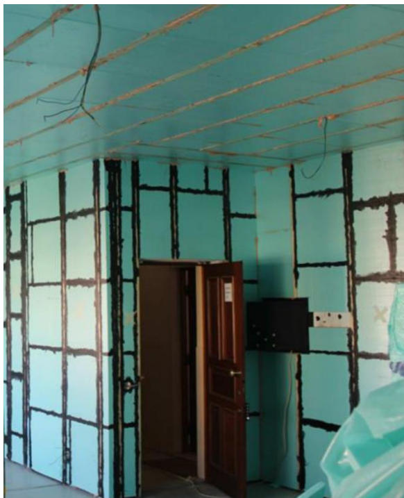
Fig. 33. Aplicação da membrana líquida para a estanqueidade (Fonte: Homegrid)
