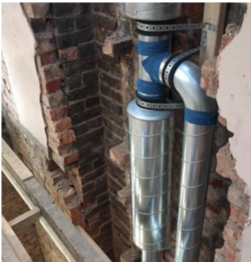
Fig. 17. Colocação de infraestruturas (Fonte: Passive House Plus )
