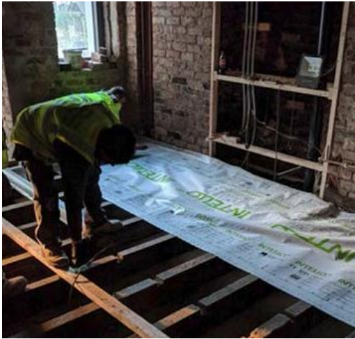
Fig. 15. Preservação das vigas originais (Fonte: Passive House Plus )
