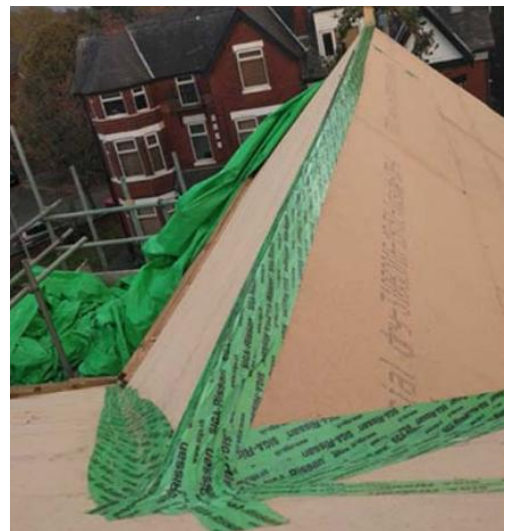
Fig. 18. Colocação da fita de estanqueidade (Fonte: Passive House Plus )
