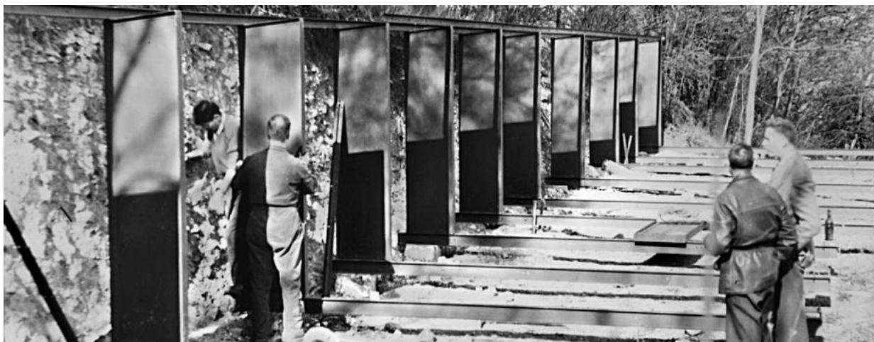
Figura 4 – Utilização de soluções pré-fabricadas para a construção da Maison Prouvé de Jean Prouvé em 1954, Nancy, França.
