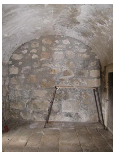
Figura 58 - Interior da capela.
