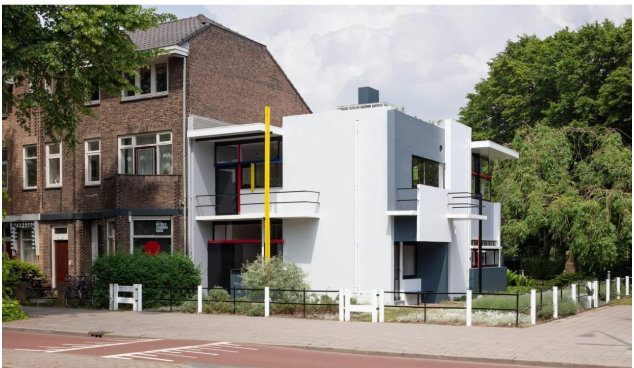
Figura 30 - Residência Rietveld Schröder do arquiteto Gerrit Rietveld, construída em 1924, em Utrecht, Holanda.
