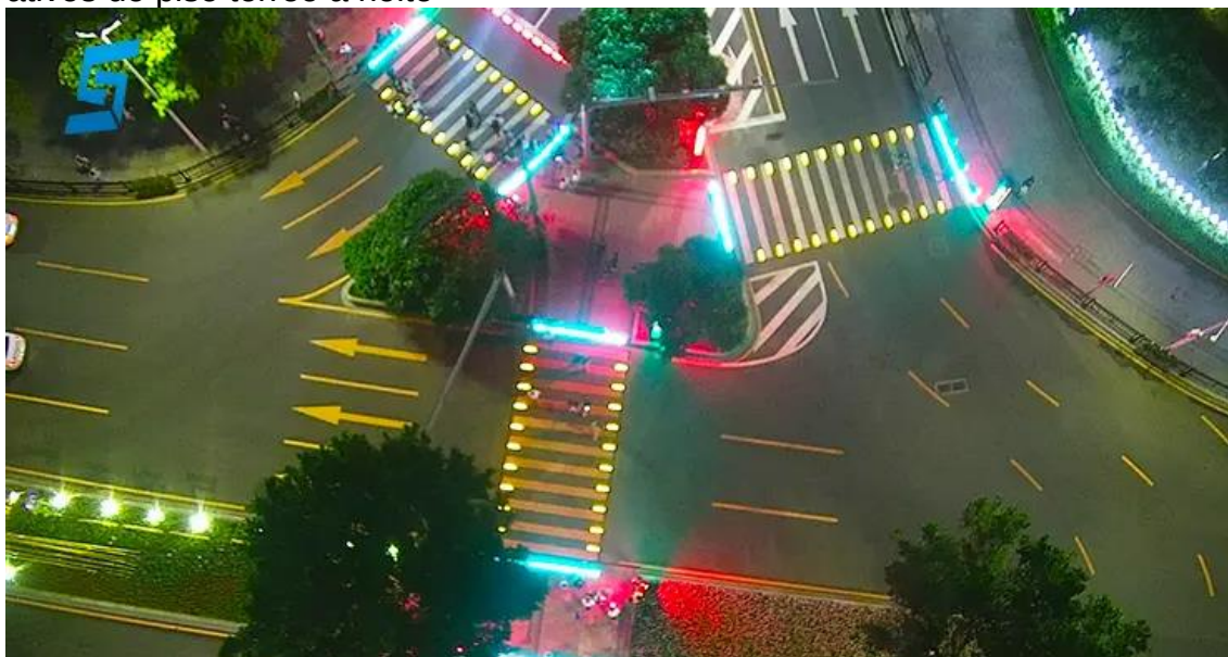
Figura 18: Passagem pedonal com iluminação
