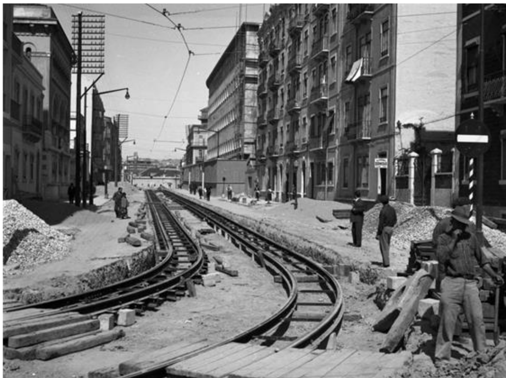
Figura 22: Obras de construção associadas à empresa de transportes públicos Carris ao longo da margem do rio, ilustrando a sobreposição histórica das infraestruturas de transporte e do espaço público. Foto de Judah Benoliel, Arquivo Municipal, Lisboa (CML).
