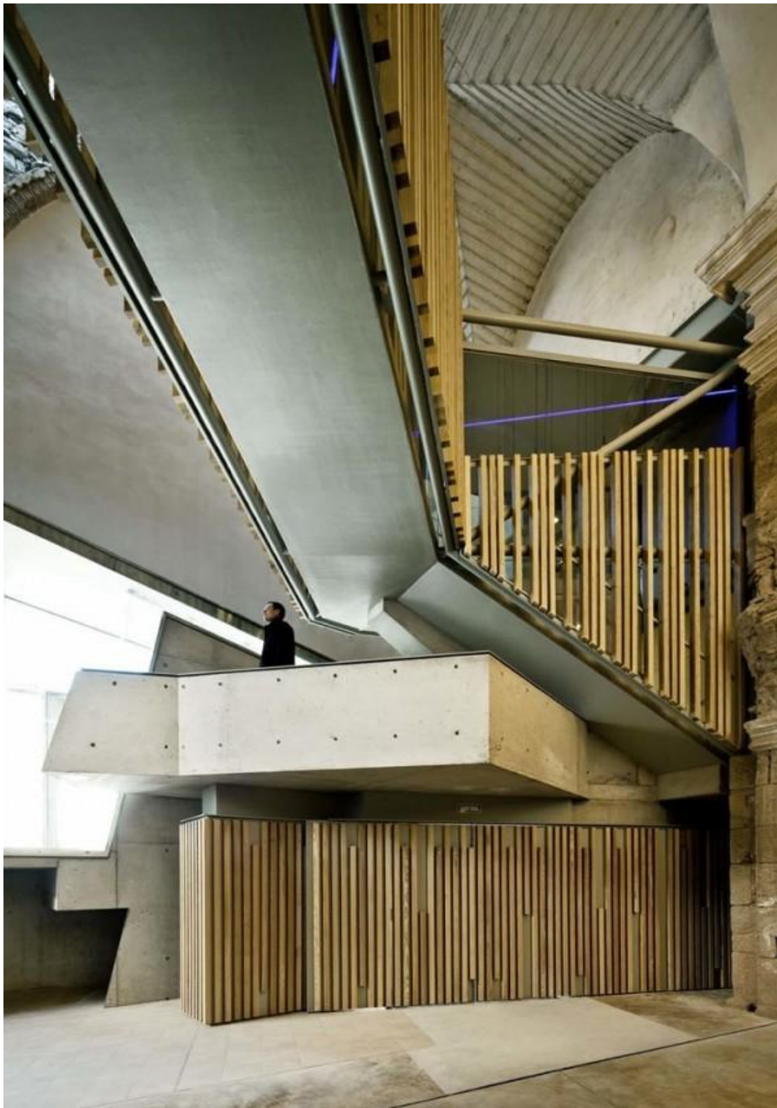
Ilustração 26: Fotografia da escadaria principal, pormenor interior, pós-reabilitação
