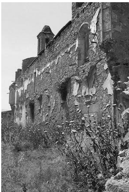
Ilustração 19: Fotografia do alçado Sul, pré-intervenção
