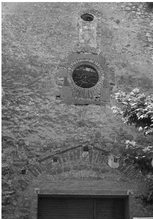
Ilustração 17: Fotografia do alçado principal, pré-intervenção
