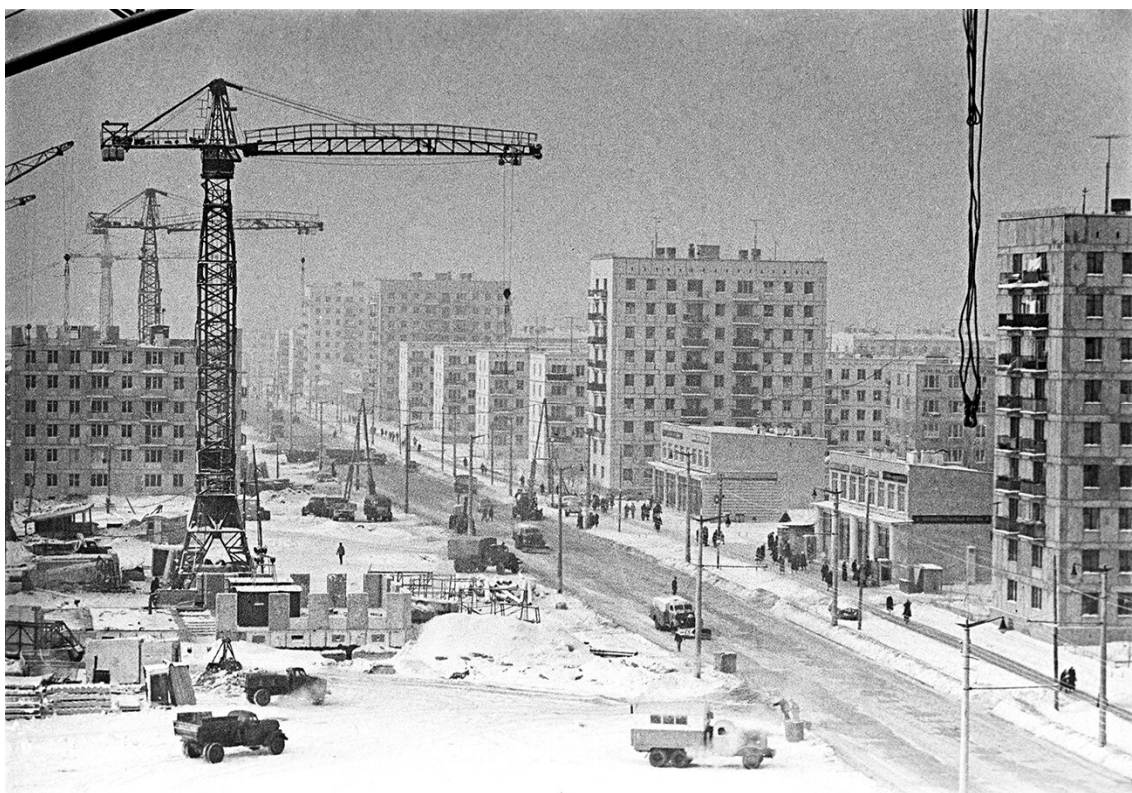
Figura 52 Construção de um novo bloco residencial em Moscovo, c. 1960 (Skuratov/Sputnik, n.d.)
