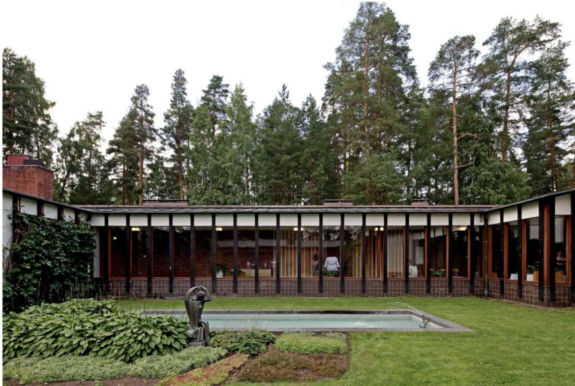
Figura 56 Alvar Aalto, Câmara Municipal de Säämätsalo, 1952, pátio central (Saieh, 2012)
