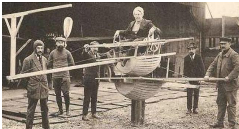
Figura 32. Primeiro simulador de voo ou barril de aprendizagem Antoniette. Fonte: Site Lintott (s.d.)
