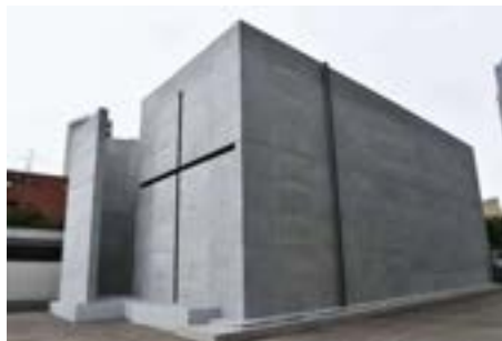
Figura 148 - Igreja da Luz, Japão (1999) - Tadao Ando Architect & Associates.
