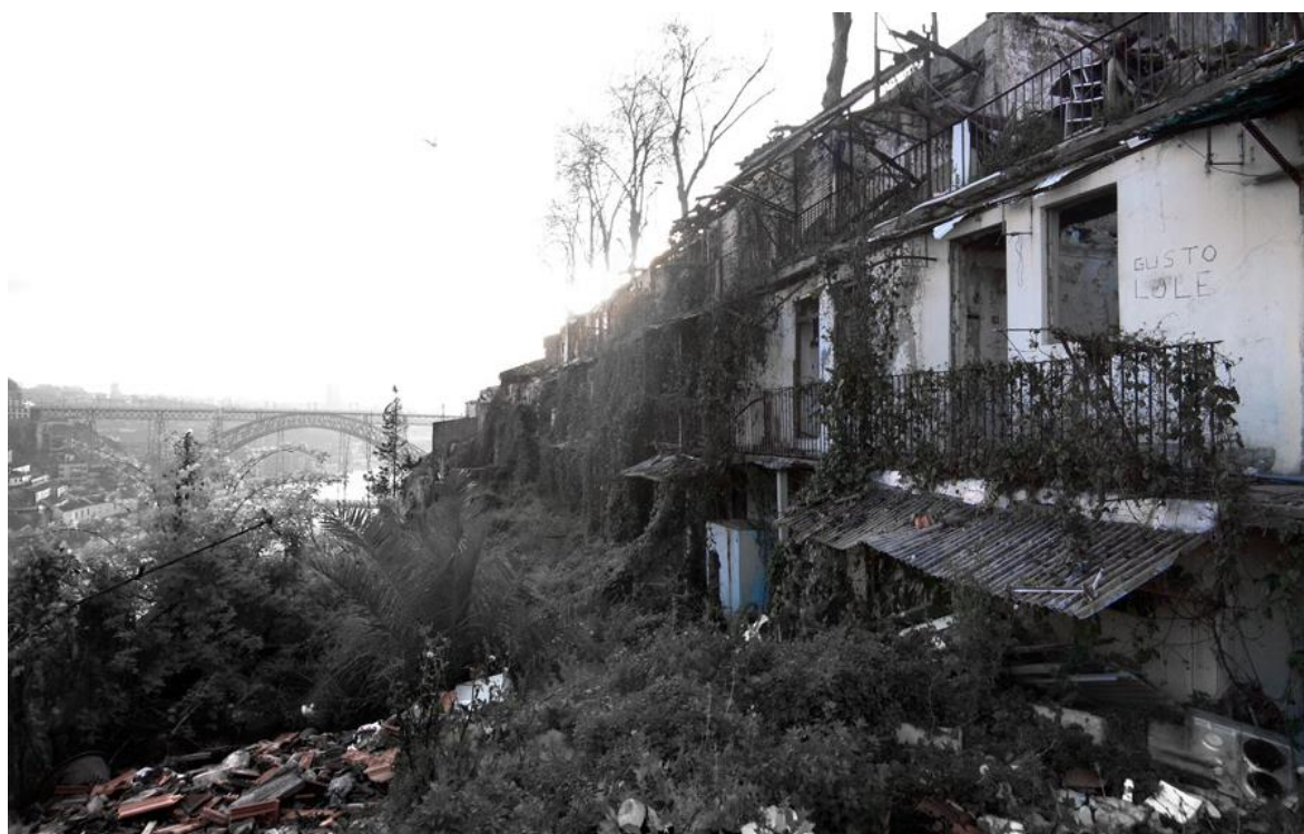
Ilustração 2 – Aspeto de uma ilha em ruína no Bairro das Fontainhas 4
