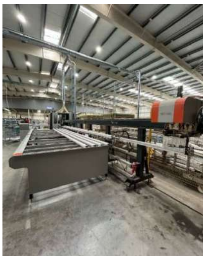
Figura 31 - Tapete de abastecimento da máquina Schtec 320
