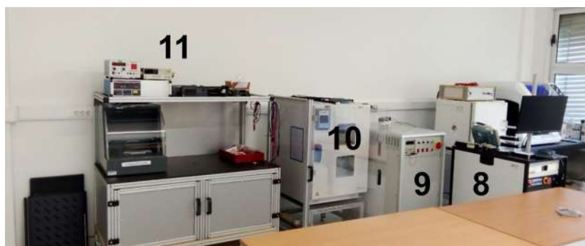
Figura 34 – Ilustração da área 8, 9, 10 e 11 do laboratório elétrico de R&D.
