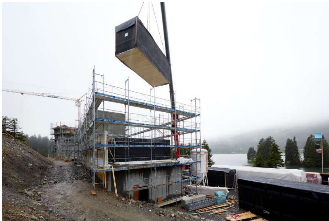
Figura 34. Módulo em Mass Timber do edifício Revier Mountain Lodge, Carlos Martinez Architekten 2017. Fonte: Lins (2017).
