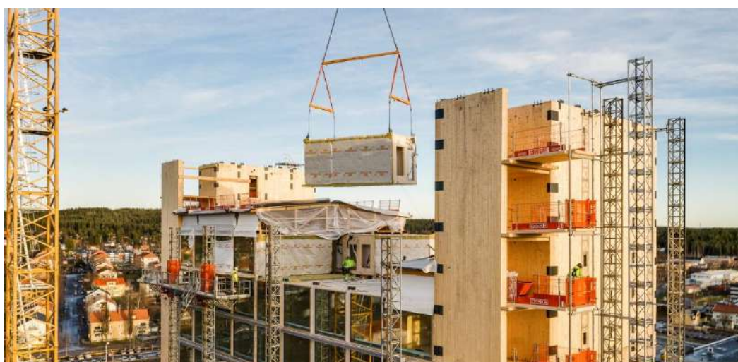
Figura 32. Construção pré-fabricada através de módulos em Mass Timber . Edifício Sara Cultural Center, Skellefteå. Fonte: Archdaily (2023).
