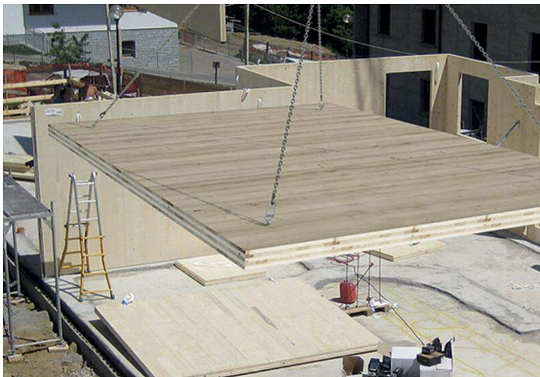
Figura 60. Transporte de placas CLT. Fonte: Rothoblaas (2024).
