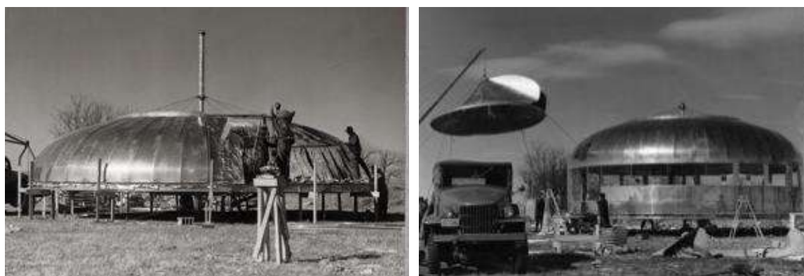
Figura 26. Montagem da Dymaxion Houses – Wichita House, Buckminster Fuller. Fonte: uckminster Fuller (2023).
