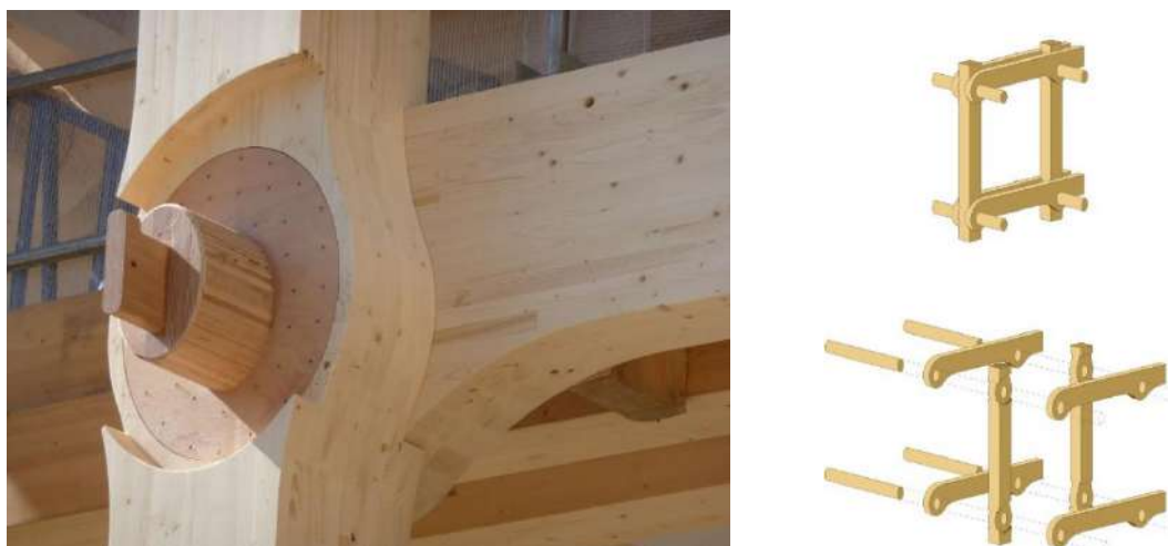
Figura 22. Sistema de ligação do edifício Tamedia Office, Shigeru Ban 2013. Fonte: Archdaily (2014)
