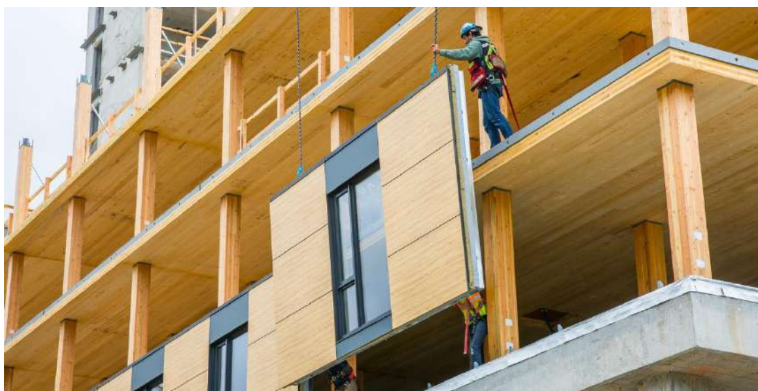
Figura 31. Módulo estrutural, Brock Commons Tallwood House. Fonte: Archdaily (2018).
