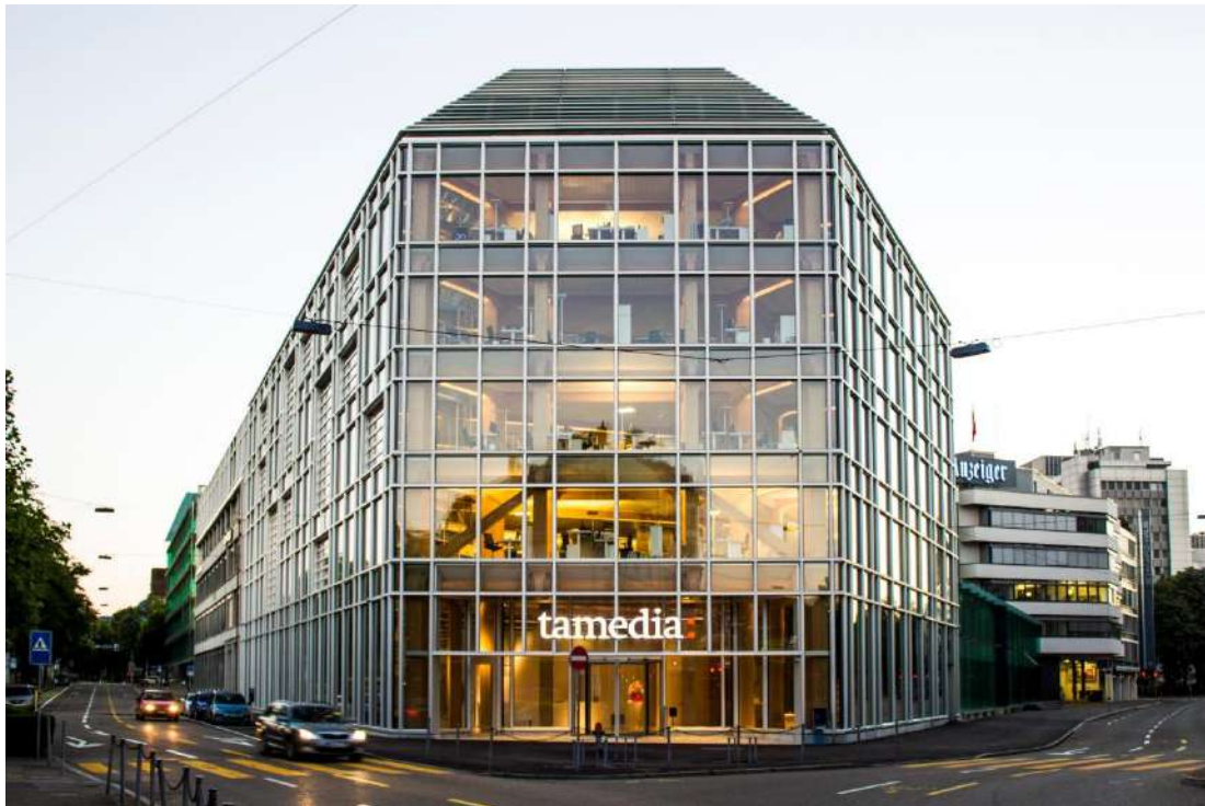
Figura 21. Tamedia Office, Shigeru Ban 2013. Fonte: Montilha et al. (2014).
