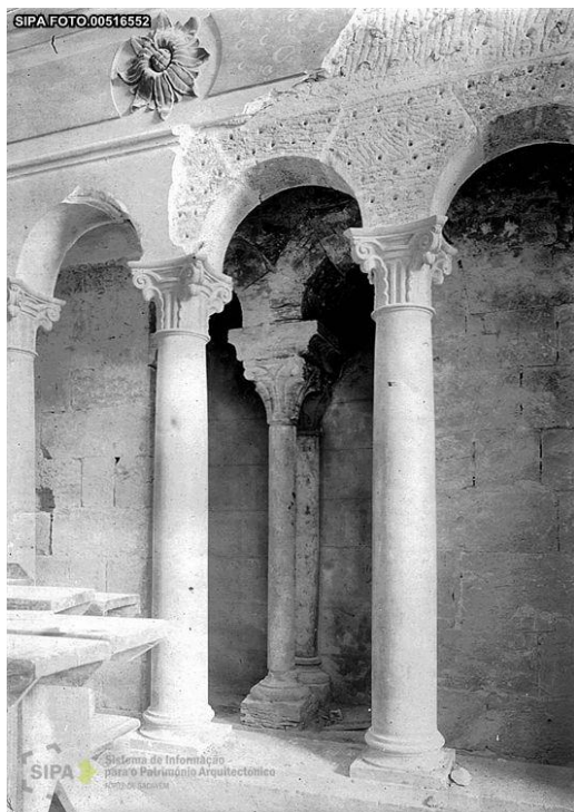
Ilustração 33 - Remoção da estucagem no trifólio da Sé de Lisboa, 1938. (SIPA)
