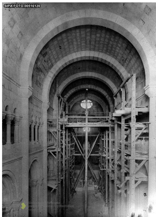
Ilustração 36 - Nave central da Sé de Lisboa após a reconstrução da cobertura, 1940-1941. (SIPA)
