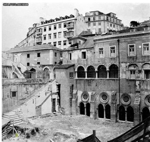
Ilustração 37 - Lateral Norte do Claustro da Sé mostrando as edificações rudimentares sobre o deambulatório, 1911-1915. (SIPA)
