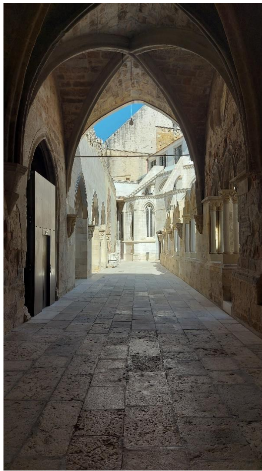
Ilustração 51 - Corredor Sul do Claustro da Sé de Lisboa após o restauro de Adalberto Dias onde se vê o novo elevador inserido entre o espaço de uma capela, 2025. (Ilustração própria)
