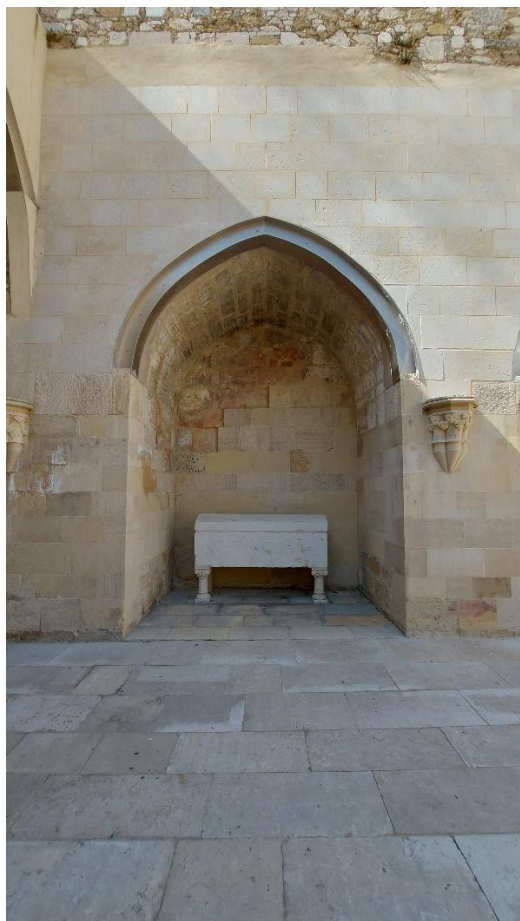
Ilustração 52 - Capela no muro Sul do Claustro da Sé de Lisboa após o restauro de Adalberto Dias onde se vê a nova estrutura de apoio, 2025. (Ilustração própria)
