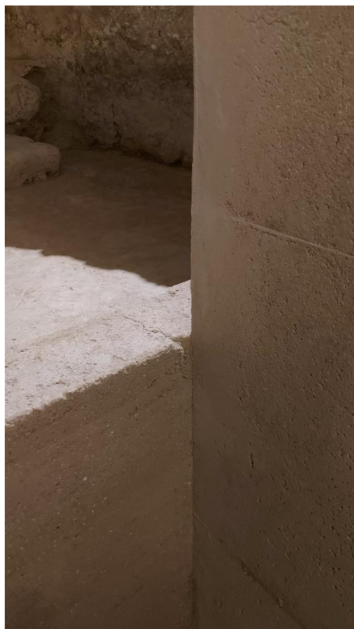
Ilustração 55 - Ponto de contacto entre o muro estrutural da nova cripta (direita) e o espaço arqueológico (esquerda), 2025. (Ilustração própria)
