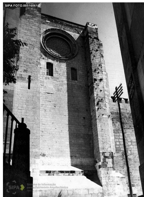
Ilustração 62 - Muro sul da Sé de Lisboa mostrando as janelas antes da intervenção de Abreu. 1930 - 1940. (SIPA)
