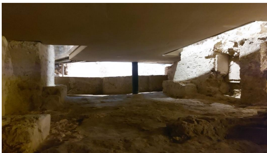
Ilustração 47 - Cripta arqueológica do Claustro da Sé de Lisboa desde o piso -2 onde se destaca um pilar estrutural que sustenta o passadiço no qual se realiza o trajeto à volta das ruínas, 2025. (Ilustração própria)
