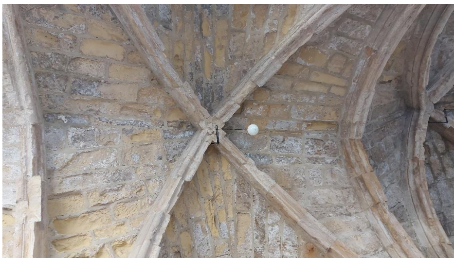
Ilustração 48 - Abóboda inalterada que forma parte do corredor lateral Este do Claustro da Sé de Lisboa, 2025. (Ilustração própria)
