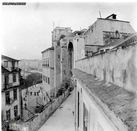
Ilustração 40 - Fotografia desde um dos edifícios amontoados sobre o muro Sul da Sé de Lisboa, 1900-1915. (SIPA)
