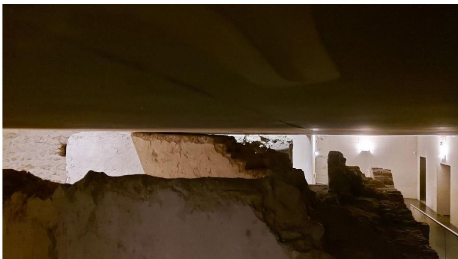
Ilustração 46 - Cripta arqueológica do Claustro da Sé de Lisboa onde se vê o piso -1 suspenso sem tocar na pré-existência, 2025. (Ilustração própria)
