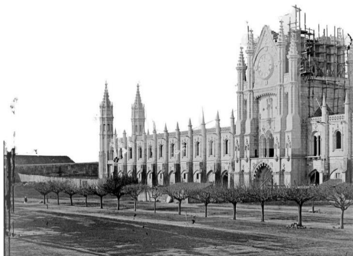
Ilustração 1 - A fachada do Mosteiro dos Jerónimos antes da derrocada, 1877. (Lisboa Antigamente)
