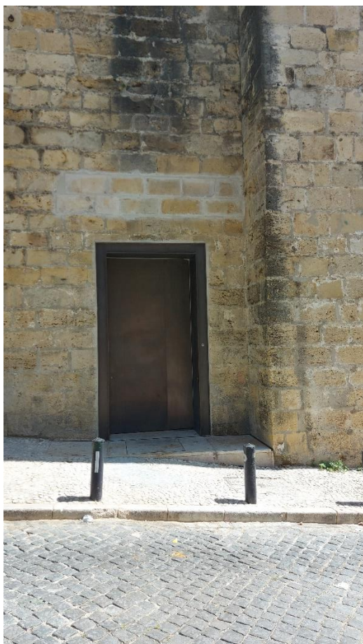
Ilustração 54 - Nova saída de emergência para o piso -2 da cripta arqueológica, inserida no muro sul da Sé de Lisboa, 2025. (Ilustração própria)
