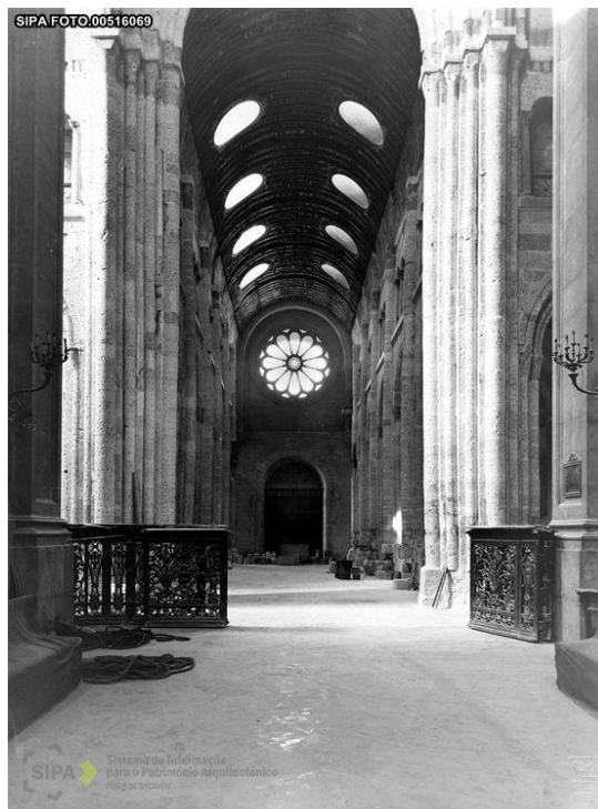
Ilustração 34 - Nave central da Sé de Lisboa após a remoção da estucagem do teto, destacando a cobertura em madeira, 1938-1941. (SIPA)
