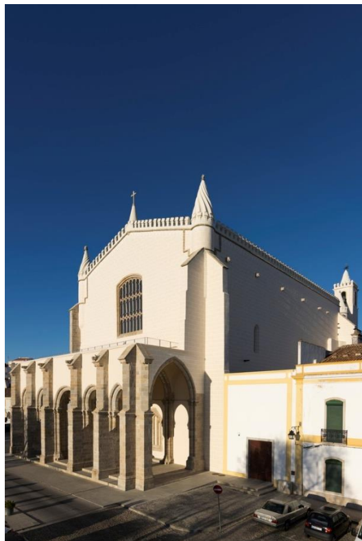
Ilustração 59 – Fachada principal do Convento de S. Francisco após a intervenção de Adalberto Dias, 2023. (Câmara Municipal de Évora)
