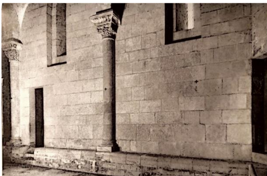
Ilustração 9 - Parede lateral direita da Sé Velha de Coimbra depois do seu restauro, 1962. (DGEMN, 1962, p. 47: Estampas)
