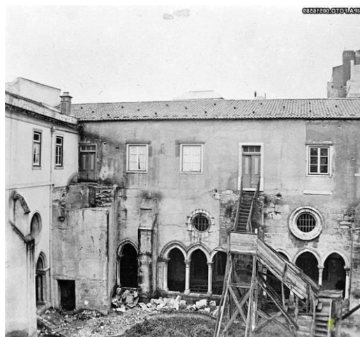
Ilustração 38 - Lateral Este do Claustro da Sé mostrando as edificações rudimentares sobre o deambulatório, 1911-1915. (SIPA)
