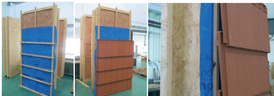
Ilustração 13 – Fases de preparação do revestimento exterior: Paineis rebocados, com uma manta geotêxtil de proteção contra a humidade e estrutura para assentamento de revestimento exterior cerâmico, Reaes Pinto.
