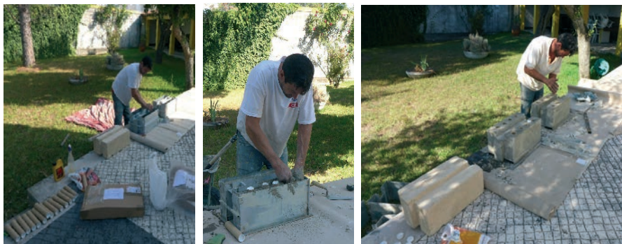
Ilustração 5 – Fases de execução dos blocos de encaixe, Reaes Pinto.
