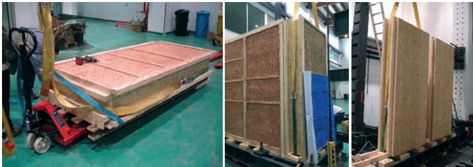
Ilustração 12 – Painel rebocado; elevação dos painéis sem placa exterior; painéis sem reboco e com placa exterior de derivados de madeira, assentes em elementos de base, Reaes Pinto.
