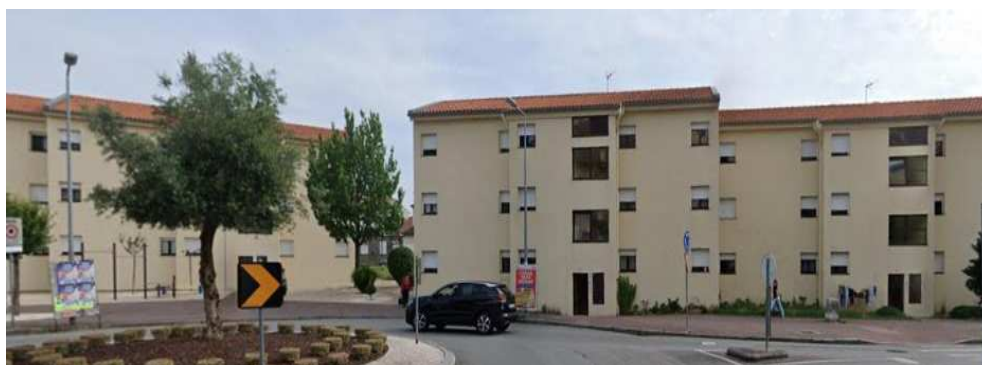
Fig.62 Vista do Bairro 1º de Maio depois de reabilitado (2023).
