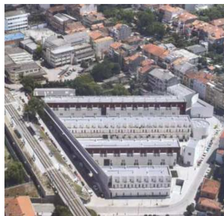
Fig. 22 Imagem aérea do Bairro da Bouça, Porto
