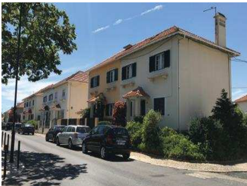
Fig. 1 Habitações Unifamiliares do Bairro de Casas Económicas da Encarnação, Lisboa
