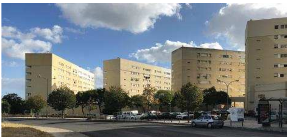
Fig. 15 Vista sobre o Conjunto Habitacional Cinco Dedos do Bairro de Chelas, Lisboa
