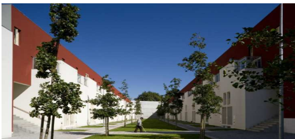
Fig. 23 Fachada posterior para o interior dos pátios comunitários do Bairro da Bouça, Porto
