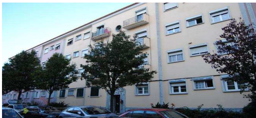
Fig. 3 Habitação Coletiva em 4 pisos do Bairro de Alvalade célula I, Lisboa
