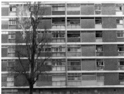
Fig. 8 Conjunto Habitacional na Avenida dos EUA, vista da fachada posterior
