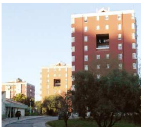
Fig.51 Edifícios em Torres por Raúl Hestnes Ferreira e Manuel Tainha (1967).
