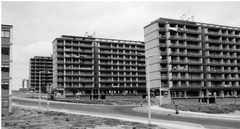
Fig. 13 Construção do Bairro dos Olivais Norte, Lisboa
