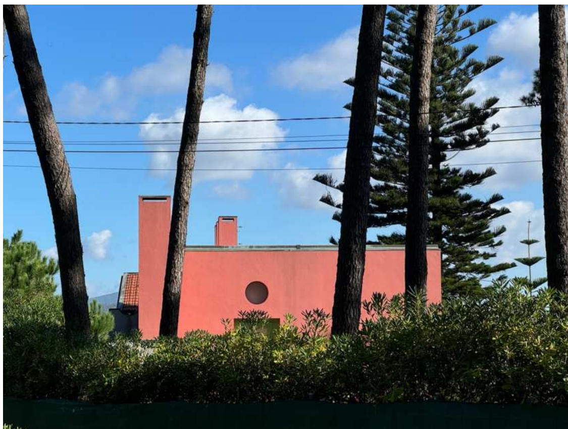
Fig. 127 | Casa Pinto de Sousa (Fonte: Fotografia da autora, 2024)
