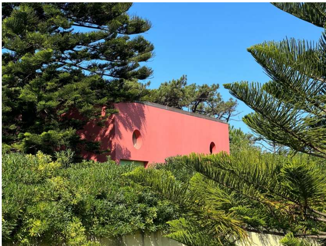
Fig. 126 | Casa Pinto de Sousa (Fonte: Fotografia da autora, 2024)
