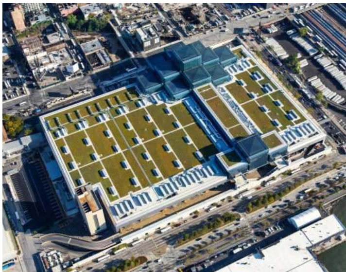
Figura 44 - Cobertura verde e arquitetura sustentável.
