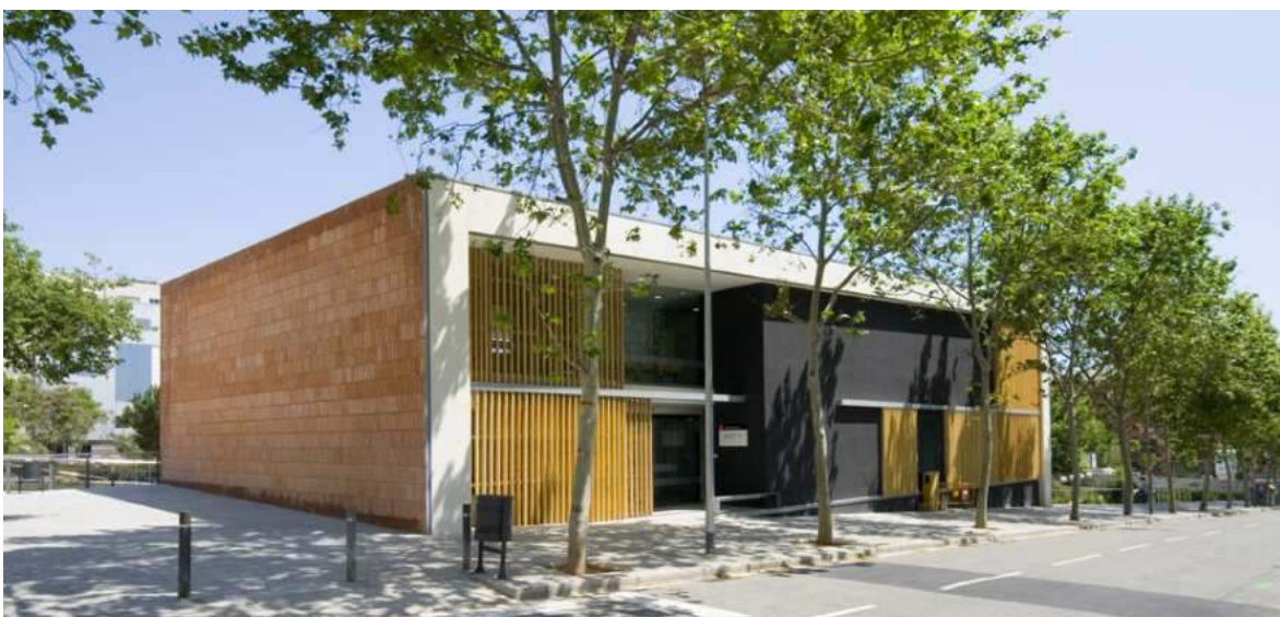
Figura 80, 81, 82 e 83 - Casa para a Terceira Idade, Barcelona.
