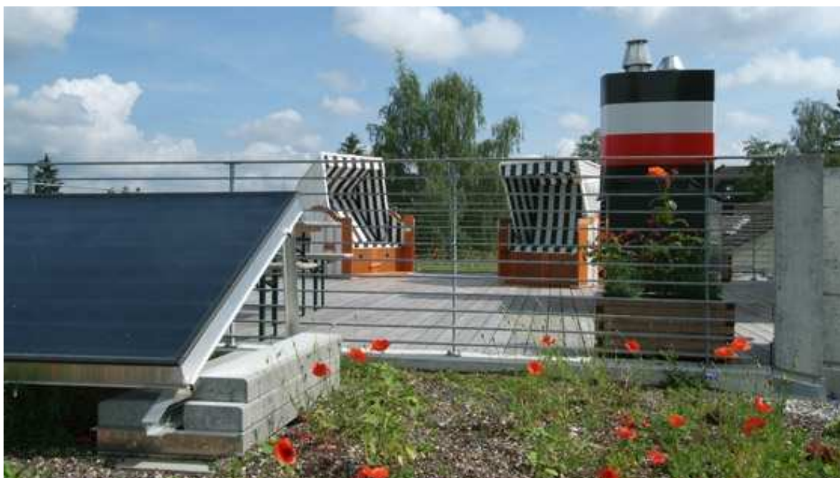
Figura 63: Vista da cobertura
