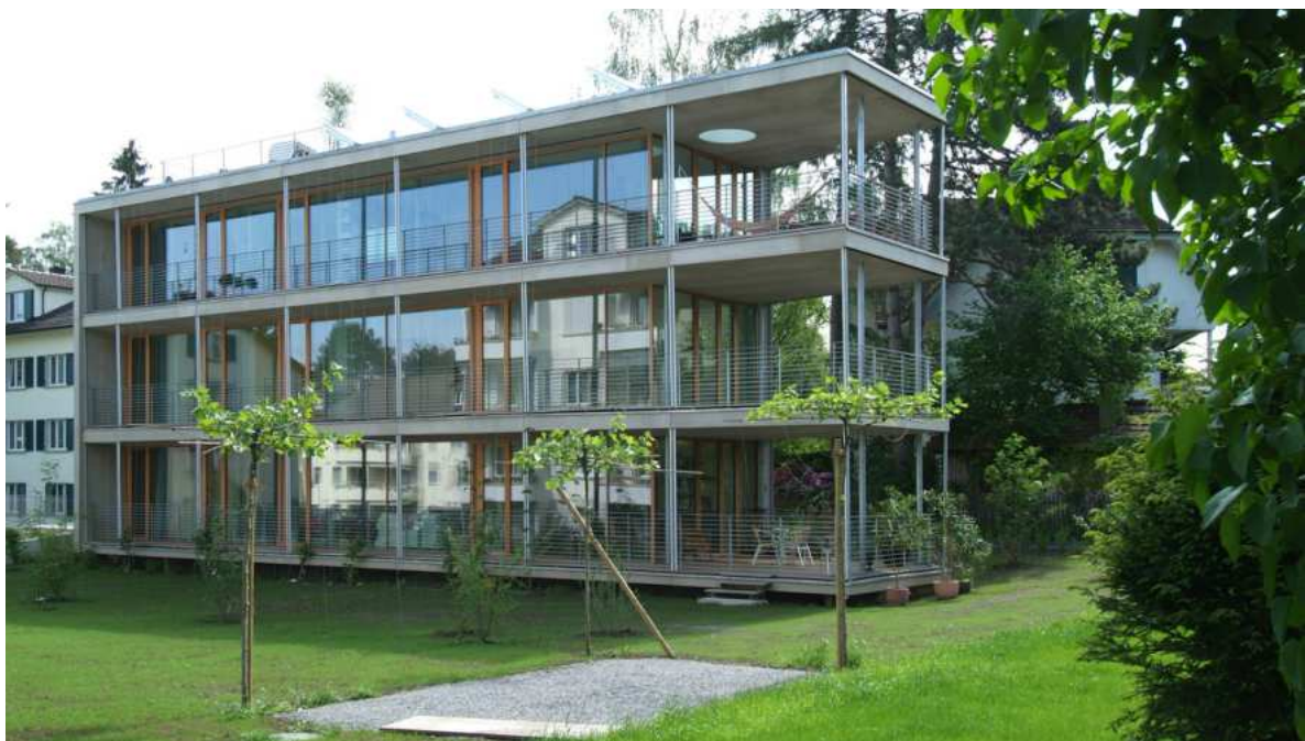
Figura 58: Vista exterior do edifício
