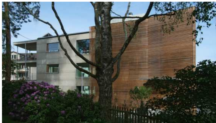
Figura 60: Vista exterior da caixa de escadas
