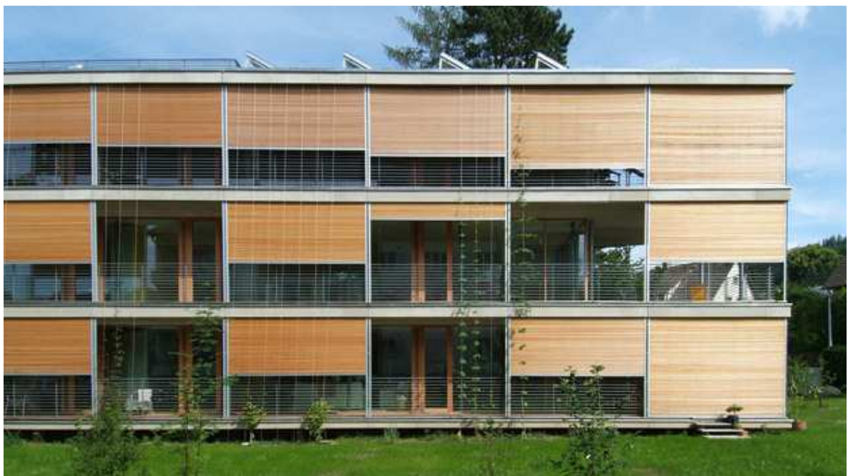
Figura 64: Vista exterior do edifício
