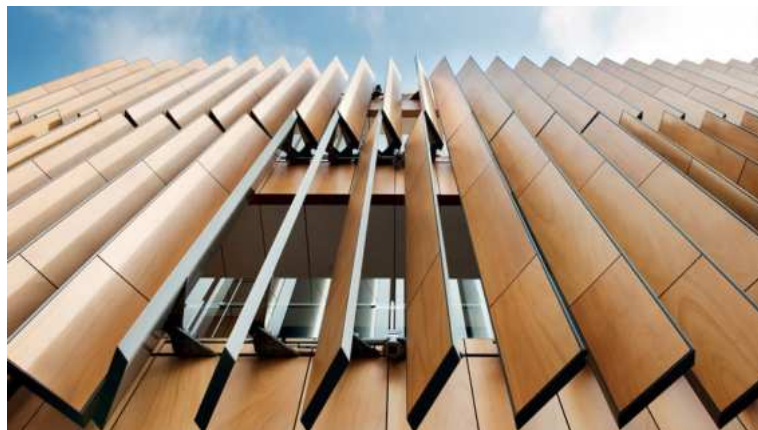
Figura 41: Edifício Biblioteca e Centro Comunitário, FJMT, Sydney (2009)
