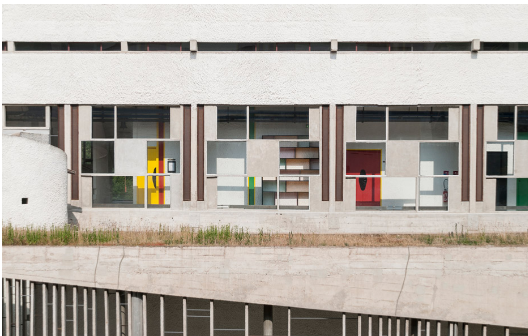
Figura 41: Fachada interior da zona Comum
