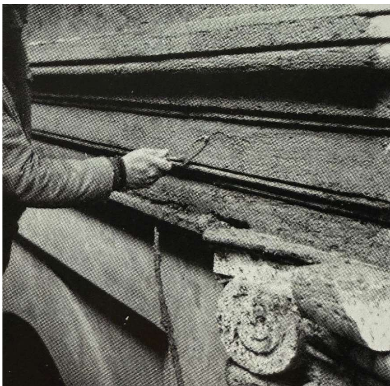
Fig. 13 – Restauro da primeira fase do reboco, com o manuseamento de uma “colher”
