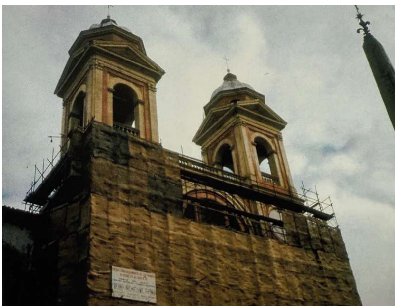
Fig. 14 – Igreja Trinità dei Monti com os andaimes a serem desmontados após intervenção
