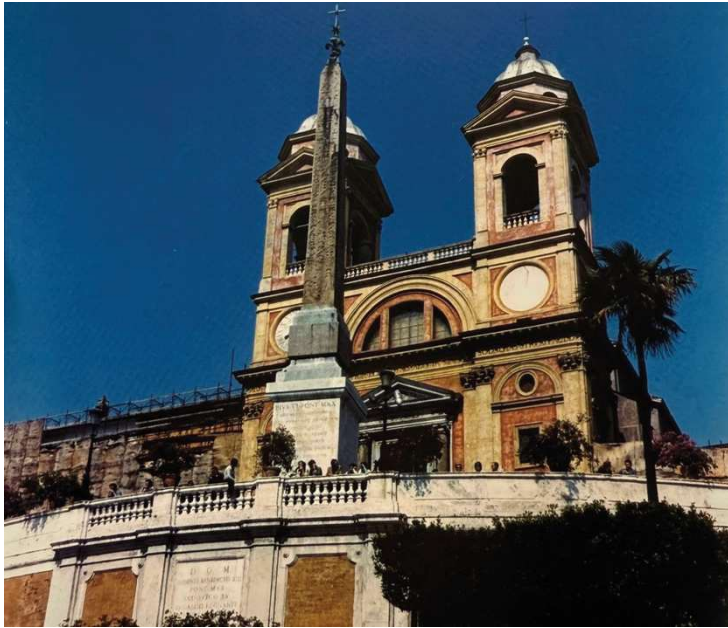
Fig. 15 - A fachada da igreja Trinità dei Monti e o convento adjacente ainda com andaimes
