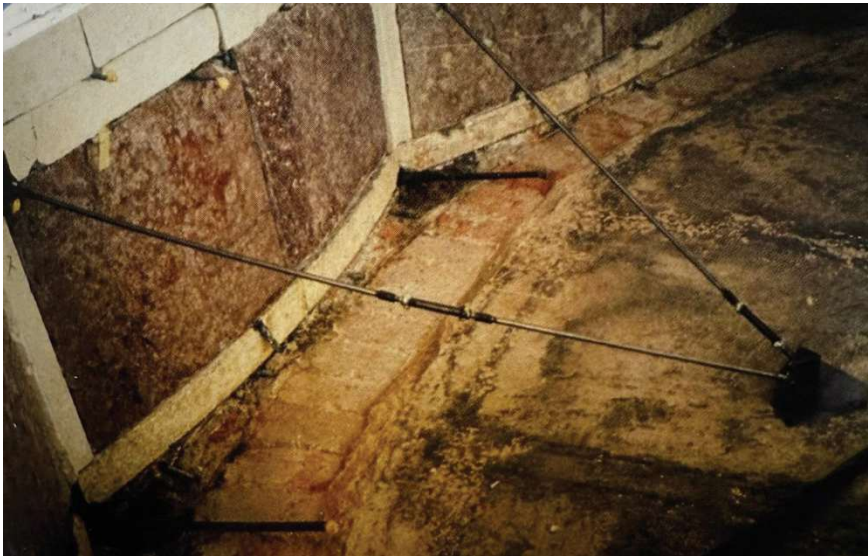
Fig 30 – Intervenção na fonte, são visíveis os tirantes que foram reprimados
