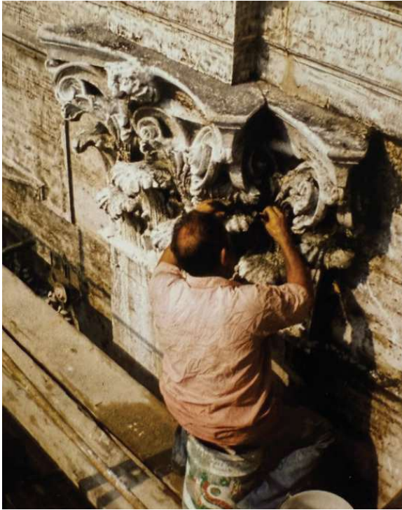
Fig. 21 - Intervenção manual na fachada, durante trabalhos
