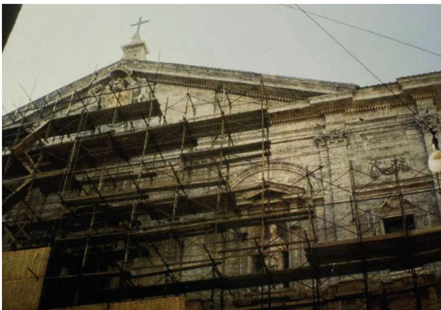
Fig. 23 - Fachada com os andaimes a serem desmontados no final da intervenção
