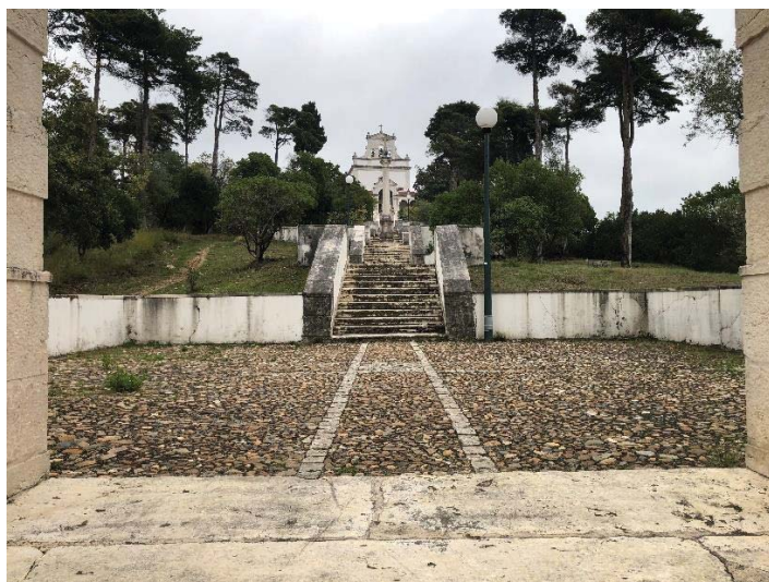
Ilustração 42 - Primeiro patamar da escadaria com enquadramento para a Igreja. Fonte: Fotografia do autor (2018).
