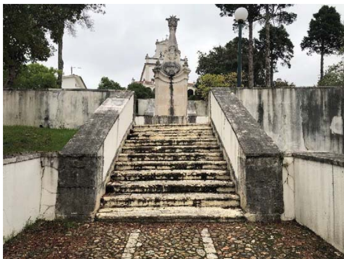
Ilustração 44 - Acesso ao terceiro patamar com fonte. Fonte: Fotografia do autor (2018).
