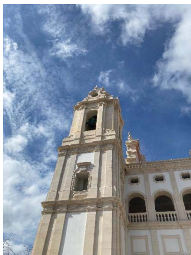
Ilustração 124 - Torre sineira do lado direito da Igreja. Fonte: Fotografia do autor (2023).
