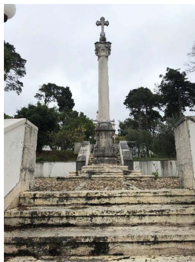
Ilustração 43 - Coluna crucifera do segundo patamar vista da escada de acesso ao mesmo. Fonte: Fotografia do autor (2018).
