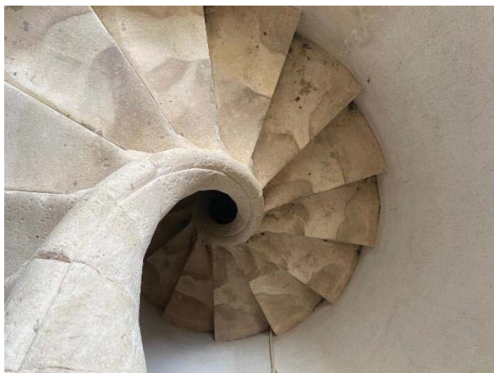
Ilustração 138 - Vista de cima da escada de pedra em caracol que faz o acesso às galilés do segundo piso. Fonte: Fotografia do autor (2023).
