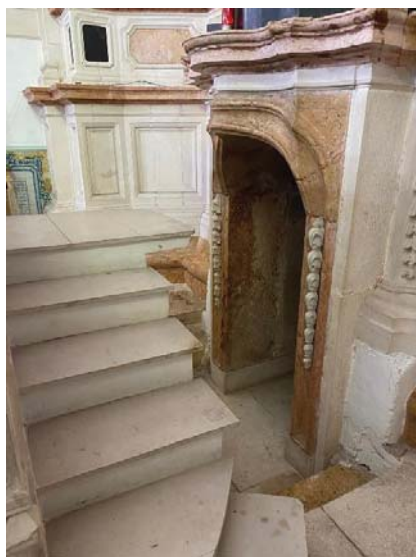
Ilustração 136 - Passagem que permite o acesso ao corpo tardoz do edifício. Fonte: Fotografia do autor (2023).
