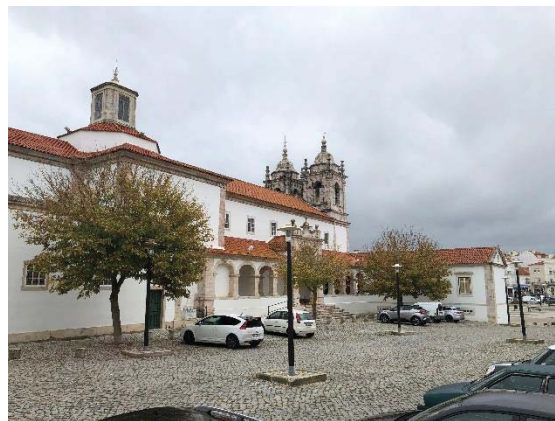
Ilustração 86 - Parte da fachada lateral esquerda com vista para a entrada para a galilé e corpo da Confraria. Fonte: Fotografia do autor (2018).
