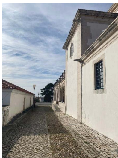
Ilustração 63 - Fachada lateral direita e casa do adro. Fonte: Fotografia do autor (2023).
