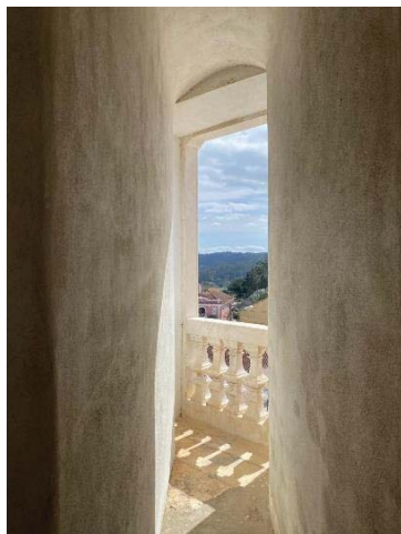
Ilustração 141 - Acesso e vão da torre direita da Igreja. Fonte: Fotografia do autor (2023).
