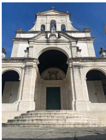
Ilustração 54 - Arco de acesso ao corpo da galilé da fachada principal. Fonte: Fotografia do autor (2023).
