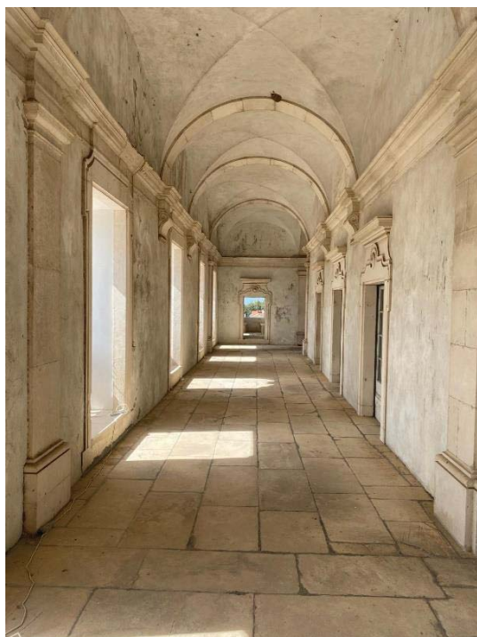
Ilustração 139 - Galilé principal do segundo piso com vista para o vão de acesso à torre esquerda da Igreja. Fonte: Fotografia do autor (2023).
