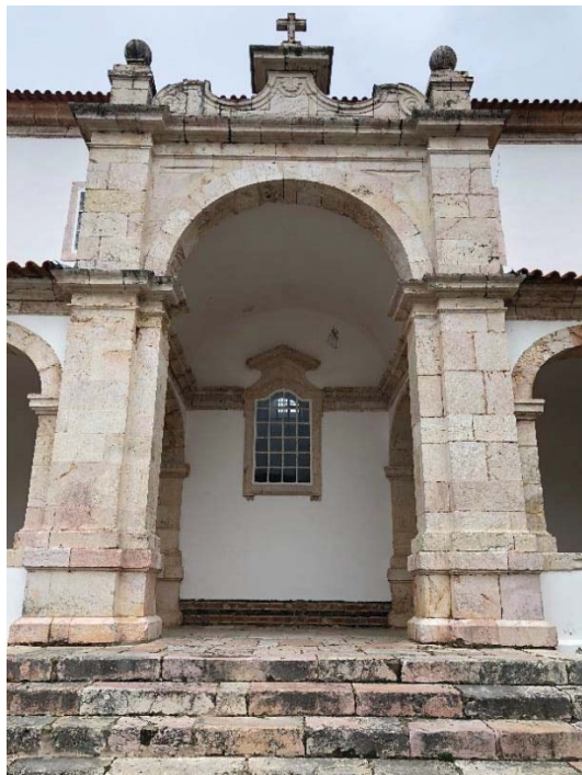
Ilustração 93 - Portal de acesso à galilé do lado direito. Fonte: Fotografia do autor (2018).
