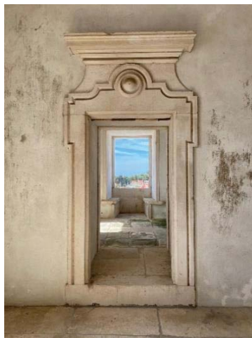
Ilustração 142 - Acesso à torre esquerda da Igreja com enquadramento para vão para a fachada lateral. Fonte: Fotografia do autor (2023).
