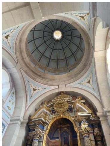
Ilustração 71 - Cúpula com lanternim da capela-mor. Fonte: Fotografia do autor (2023).
