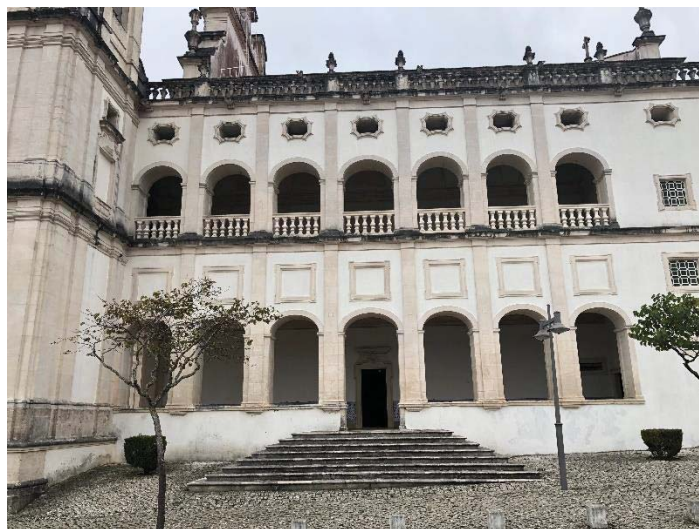
Ilustração 123 - Parte da fachada e acesso ao edifício a partir da galilé do lado direito. Fonte: Fotografia do autor (2018).
