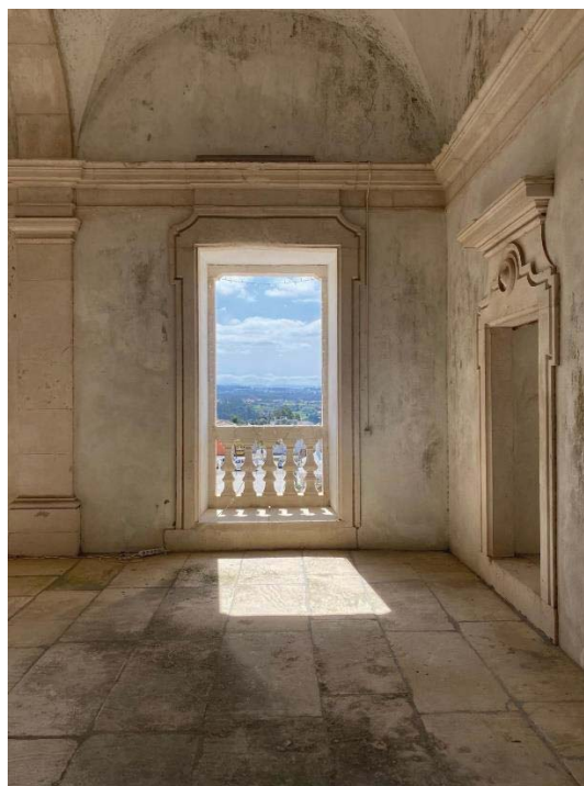
Ilustração 140 - Vão da galilé da fachada principal com acesso à torre esquerda da Igreja. Fonte: Fotografia do autor (2023).
