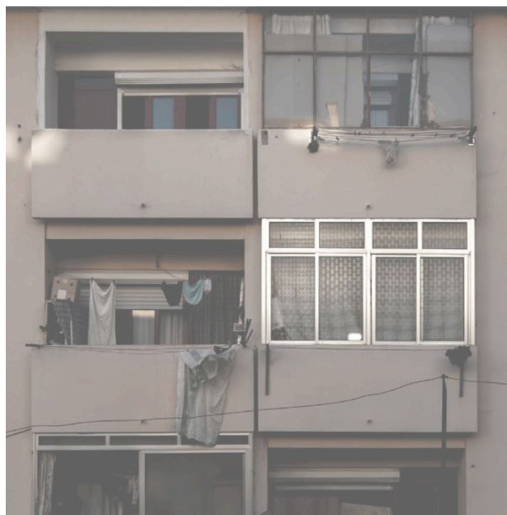
Fig. 125 Fachada com alguns encerramentos da varanda. Autor:desconhecido.
