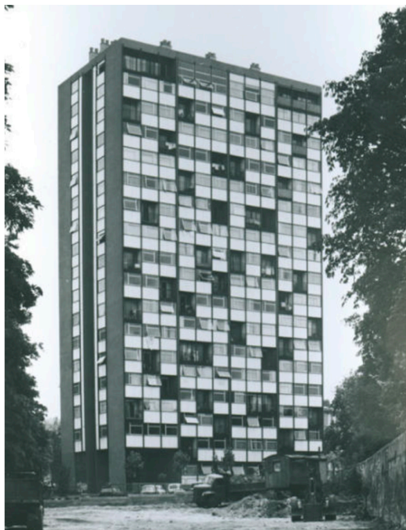
Fig. 83 Torre Bois Le Pretre em 1959. Autor: Raymond Lopez.
