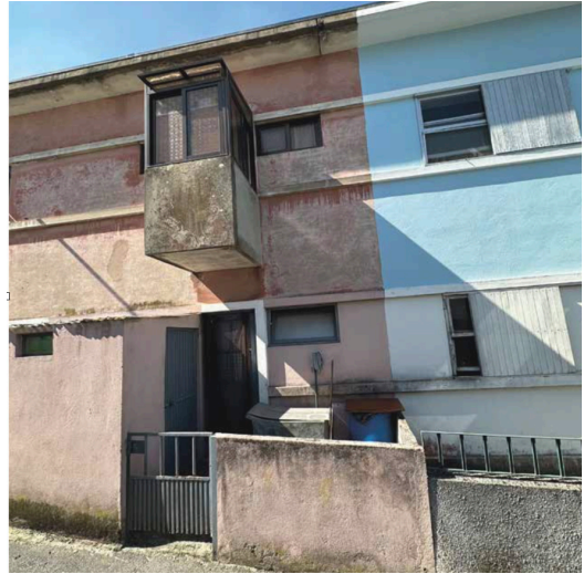
Fig. 165 Encerramento da varanda e dos logradouros.
