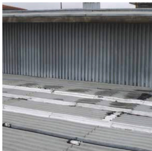
Fig. 162 Detalhe da cobertura.
