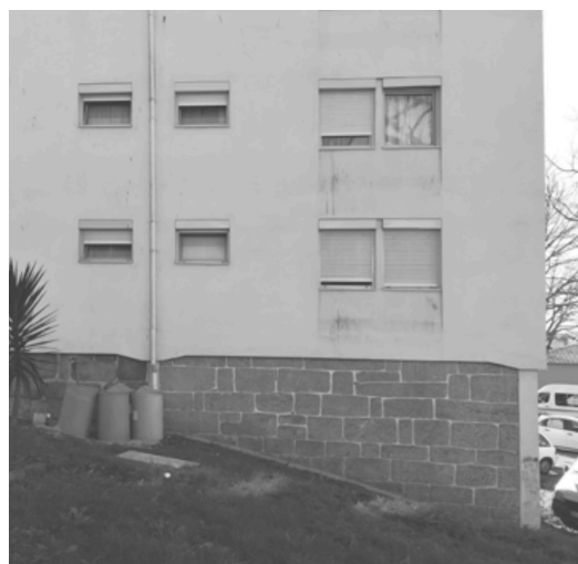
Fig. 102 Pormenor do granito na fachada. Autor: desconhecido.
