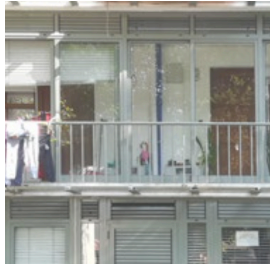
Fig. 110 Pormenor do encerramento da galeria. Autor: desconhecido .
