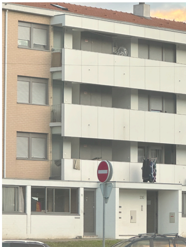
Fig. 136 A fachada depois da intervenção.
