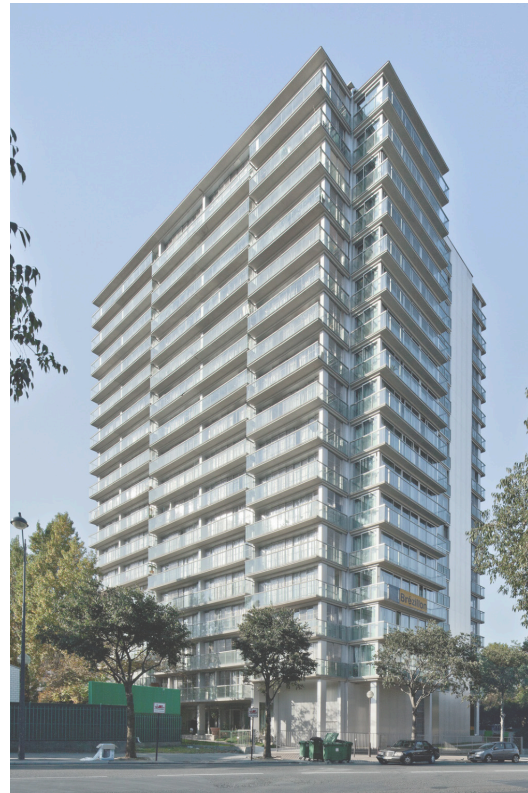
Fig. 95 Edifício depois da reabilitação. Autor: desconhecido.
