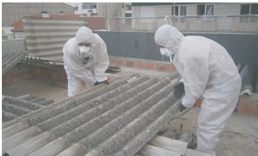
Fig. 45 Remoção de coberturas em fibrocimento contendo amianto. Autor: desconhecido.
