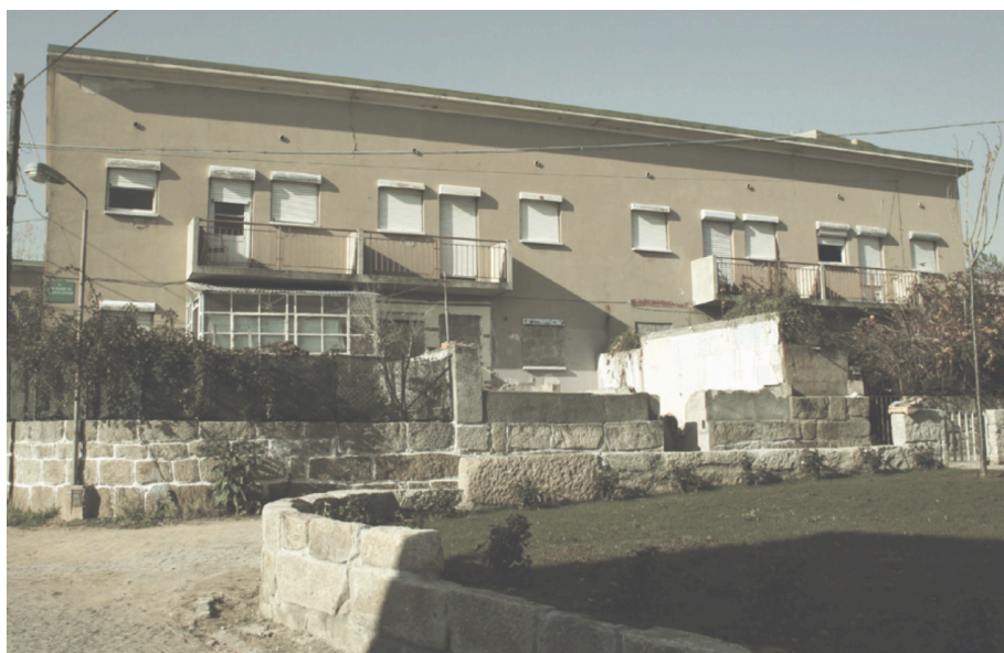
Fig.62 Fotografia de um dos blocos do Bairro da 1ª fase antes da reabilitação, que mostram a varanda e o espaço exterior de cada habitação no r/chão. Autor: desconhecido.
