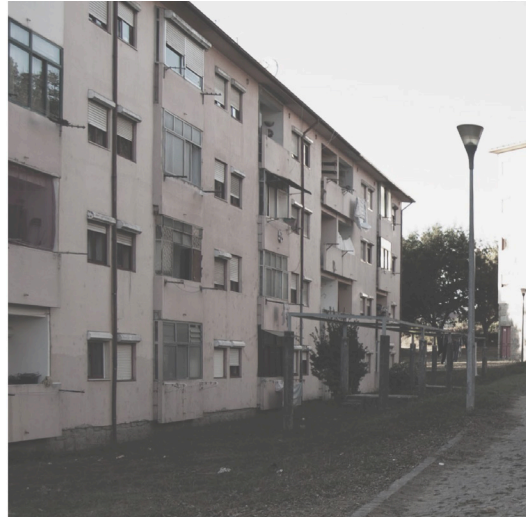
Fig. 121 Fachada com alguns encerramentos da varanda. Autor:desconhecido.
