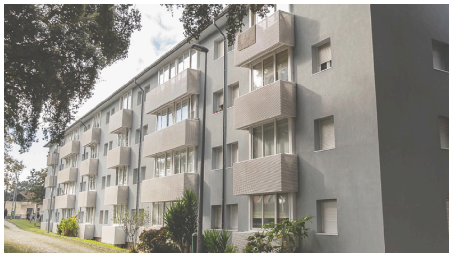
Fig. 132 A fachada depois da segunda intervenção. Autor: desconhecido.
