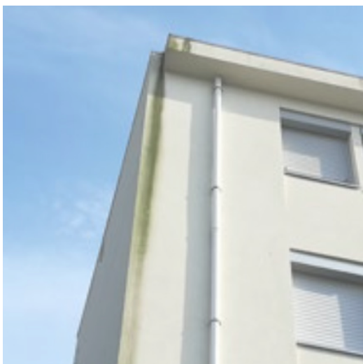
Fig. 115 Estado atual da fachado do edifício depois da reabilitação. Autor: desconhecido.
