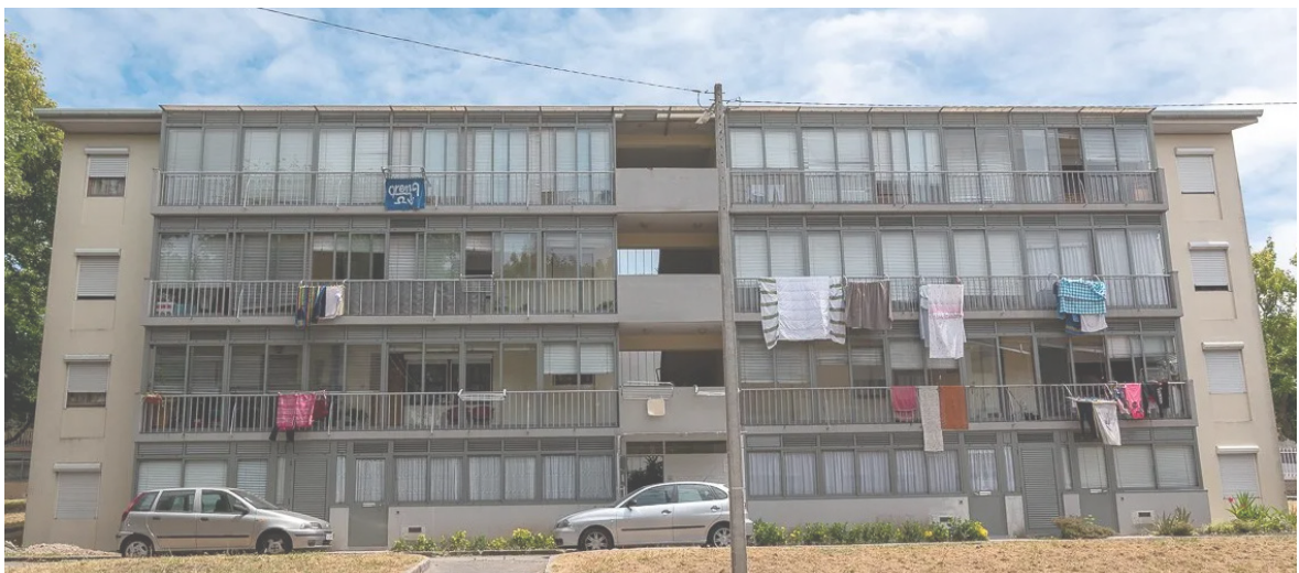
Fig. 111 A fachada depois da reabilitação. Autor: desconhecido.
