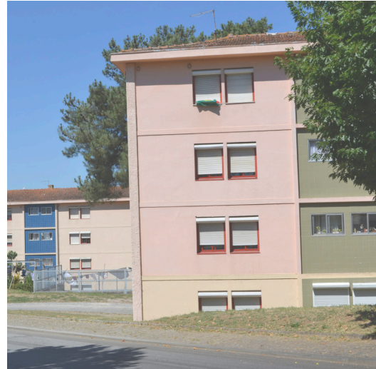
Fig. 130 As fachadas após da primeira intervenção. Autor: desconhecido.
