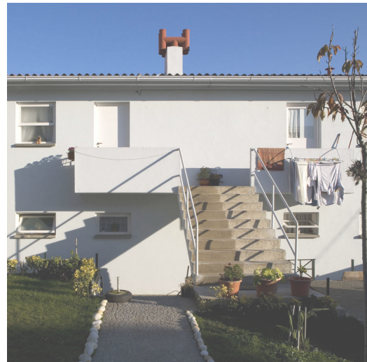
Fig. 81 Fachada com o acesso em galeria depois da reabilitação. Autor: Ana Lima.
