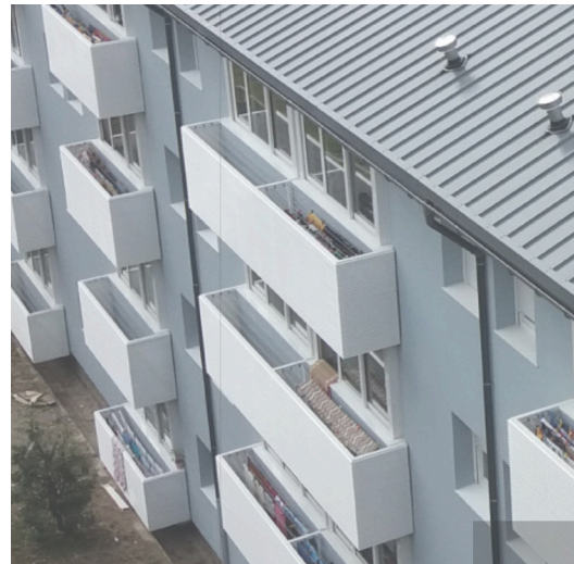
Fig. 131 Pormenor das estruturas metálicas. Autor: desconhecido.
