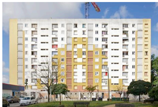
Fig. 56 O edifício Cité du Grand Parc antes da reabilitação. Autor: desconhecido.
