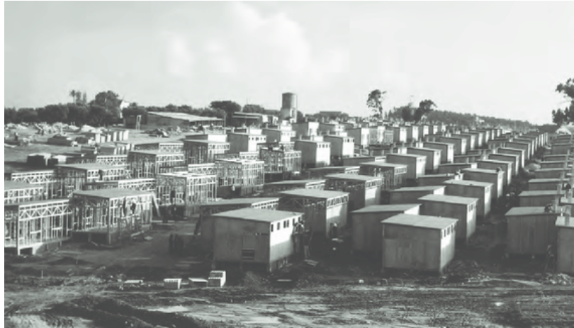
Fig. 30 Bairro de Casas Desmontáveis da Quinta da Calçada, em construção, Lisboa, 1939 (CML, 1938 -1939). Autor: desconhecido.
