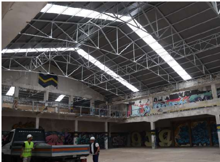
Figura 61 - Foto do interior da nave central, 2023. Fonte: Autor
