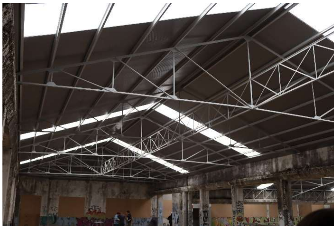
Figura 63 – Foto do piso superior que demonstra a estrutura metálica do telhado, 2023. Fonte: Autor
