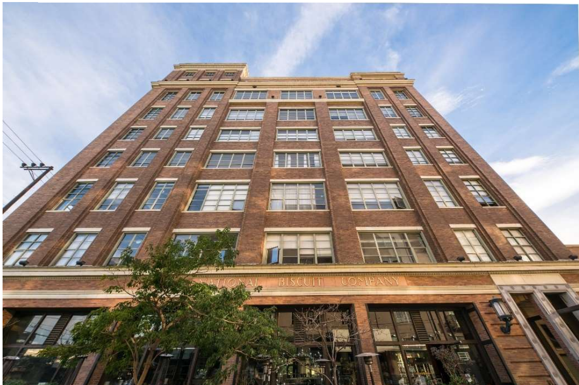
Figura 52 - Foto exterior do edifício The Biscuit Company Lofts. Fonte: Artigo Variety.
