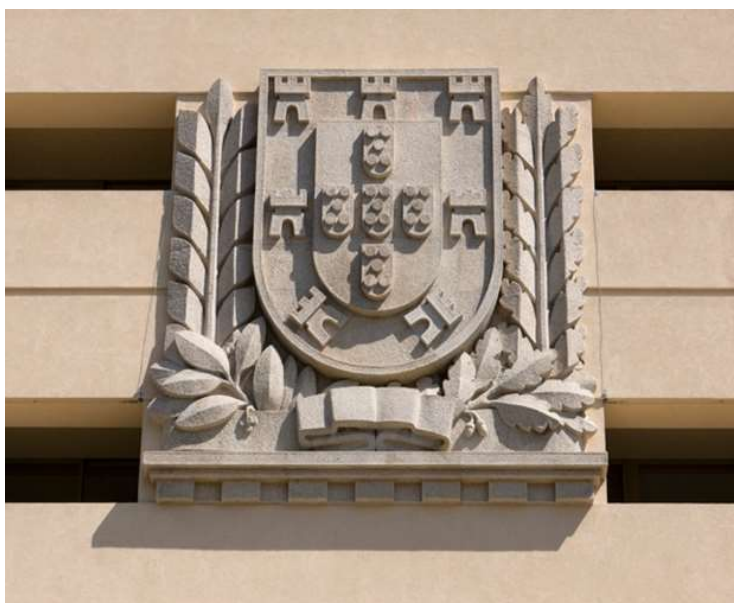
Figura 27 - Brasão de armas inserido na fachada do Armazém frigorífico preservado na sua reconversão para habitação. Fonte: Site do arquiteto Carlos Prata
