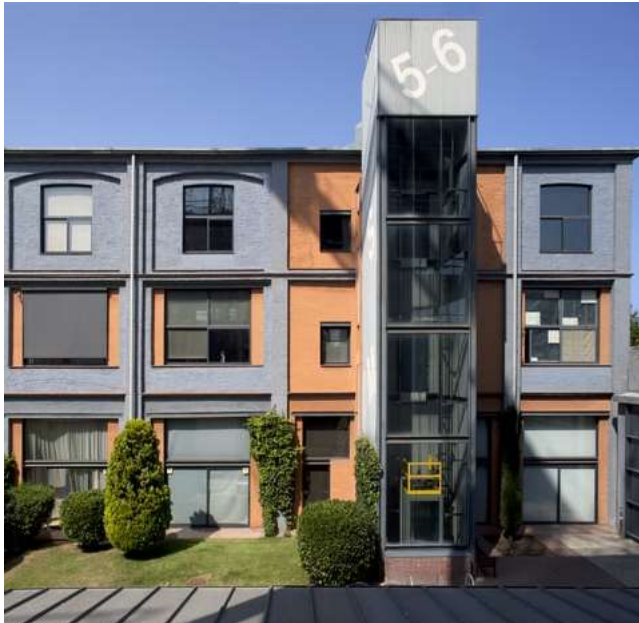
Figura 32 – Módulo vertical inserido no contexto da fachada do edifício Vapor Lull. Fonte: arquitecturacatalana.cat
