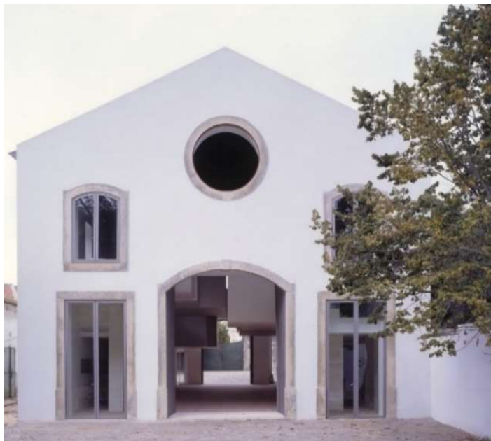
Figura 43 - Fachada da Casa de Brejos de Azeitão. Fonte: El Croquis Aires Mateus, 2016
