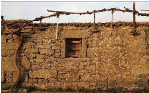
Figura 23: Arquitetura vernacular portuguesa - sistema de suporte
