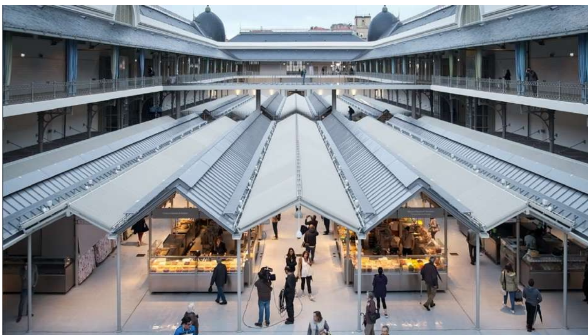
Figura 14: Mercado do Bolhão depois da reabilitação
