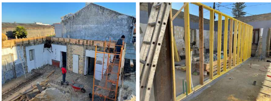
Figura 74: Estrutura das paredes interiores – antes e durante a obra
