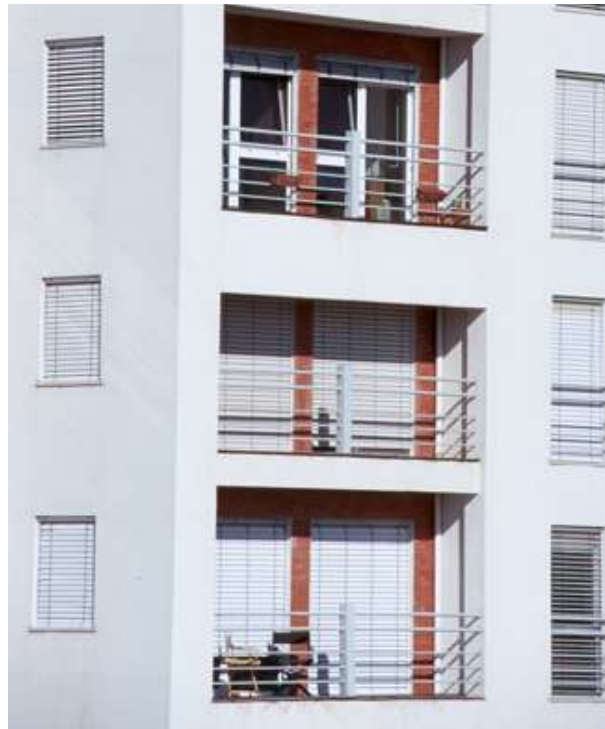
Figura 58: Detalhe da fachada
