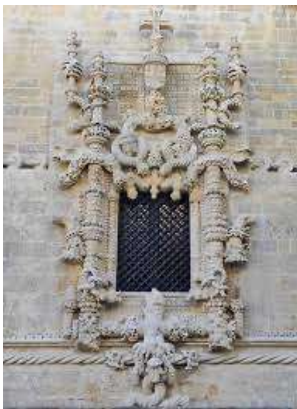
Figura 16: Janela Manuelina do Claustro de Santa Bárbara, Convento de Cristo, Tomar (depois do restauro)
