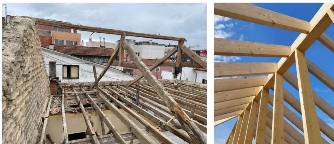
Figura 73: Estrutura de madeira – antes e depois
