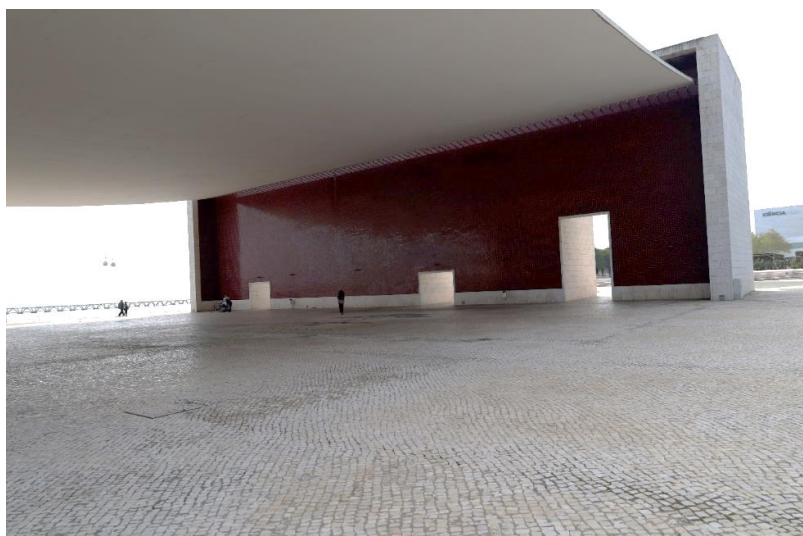
Ilustração 75 – Fachada interior nascente, Pavilhão de Portugal Expo'98, Lisboa. (Ilustração nossa,2024).
