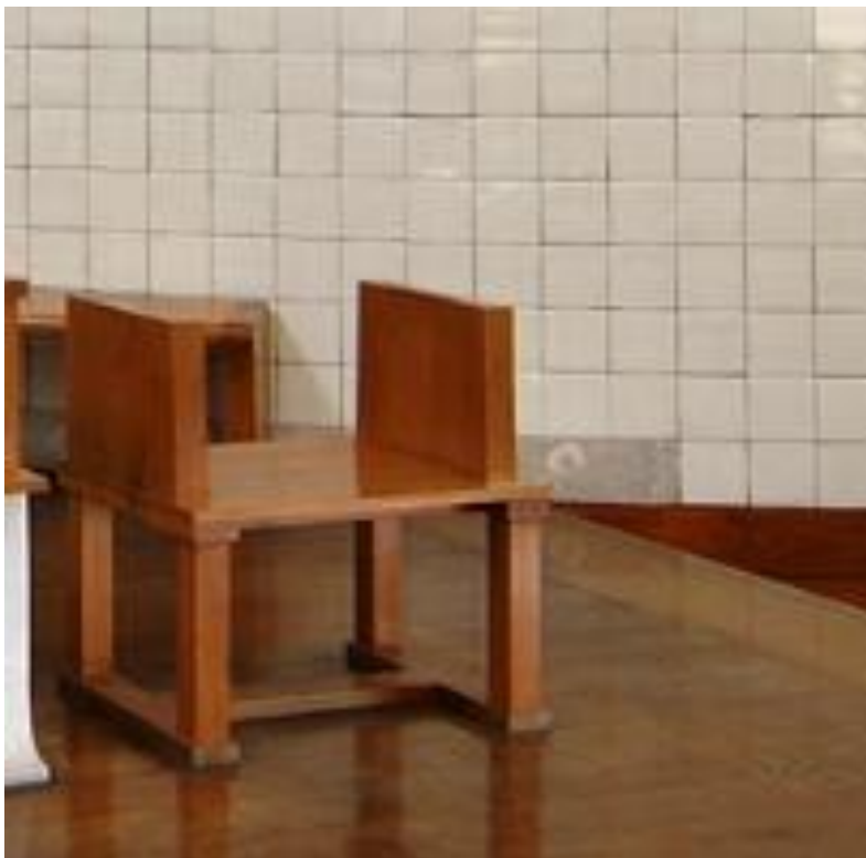
Ilustração 38 – Transição entre materiais: lambrim e rodapé (Fotografia: Petr Šmídek, 2011),
