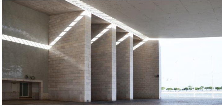
Ilustração 76 – Revestimento em azulejo cinza e pedra de lioz dos porticos.
