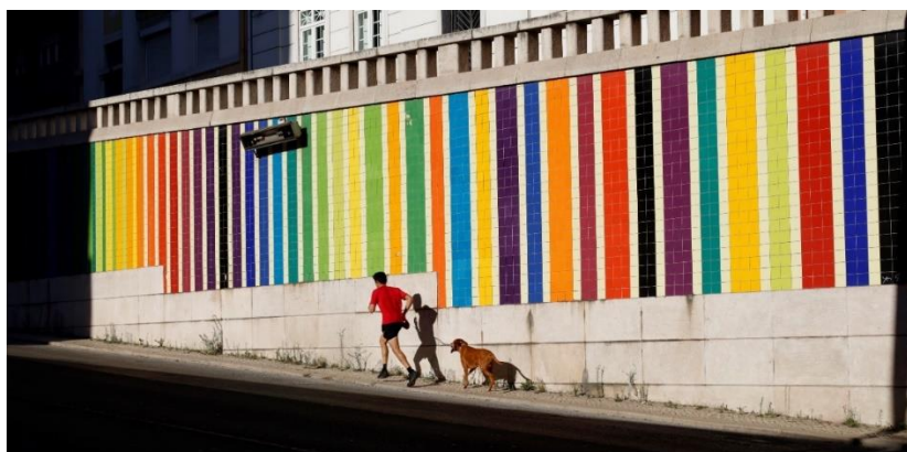
Ilustração 23 – Viaduto Av. Infante Santo, Lisboa. (Ilustração nossa, 2024).
