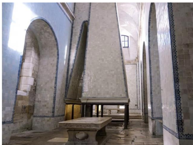
Ilustração 67 – Mosteiro de Santa Maria de Alcobaça, revestimento da cozinha com azulejos de diferentes tons de esmalte e ondulação superficial da chacota, devido à cozedura artesanal (Alcobaça 1752). https://www.almadeviajante.com/wp-content/uploads
