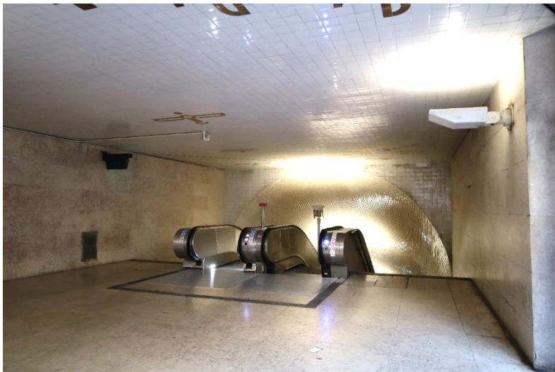
Ilustração 66 – Revestimento empedra e azulejo. Saida para o Largo do Chiado. Lisboa. (Ilustração nossa, 2024).
