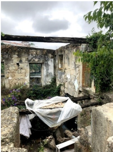
F1-Estado conservação da cobertura
