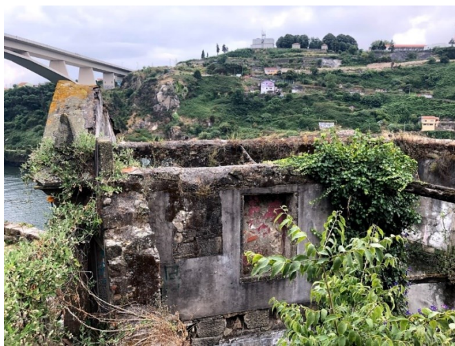
F2-Estado conservação da cobertura
