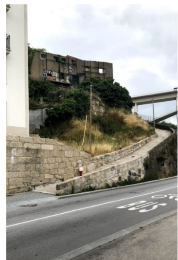
F5-Estado conservação geral do edificio
