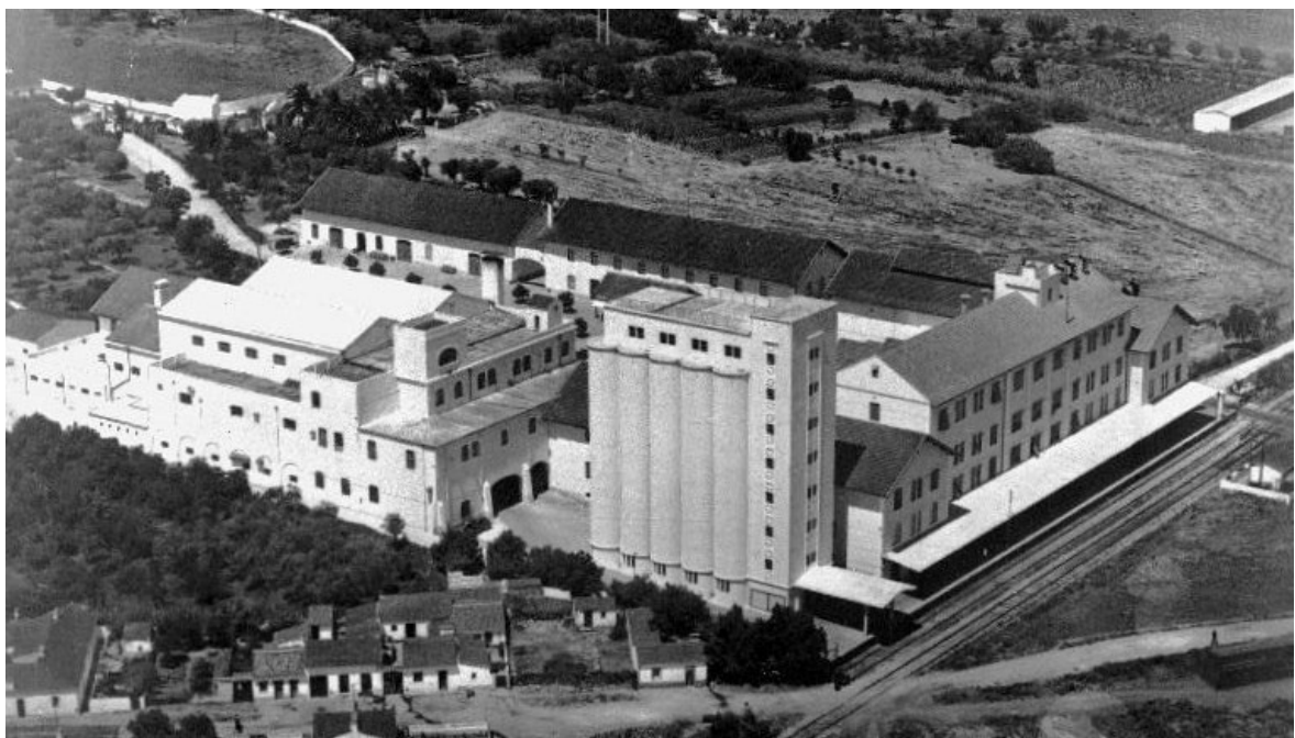
Figura 10- Vista aérea da Fábrica dos Leões.
