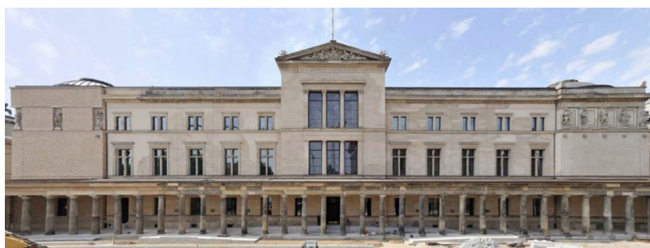
Figura 21 – Fachada Este do Neues Museum
