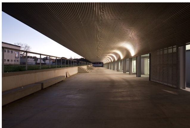
Figura 15 - Telheiro de ligação entre edifícios.
