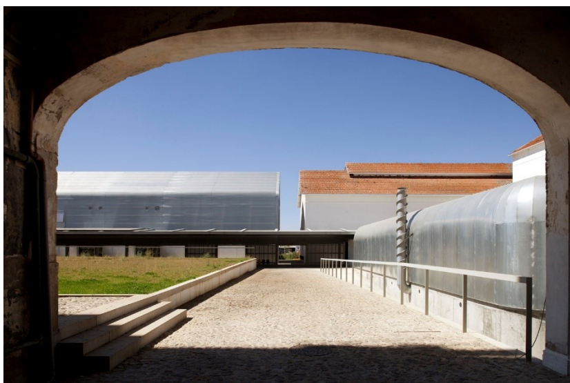
Figura 18 – Vista lateral, edifício de Artes Visuais e Multimédia.
