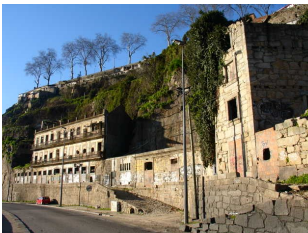
Figura 33 - Parte da Fábrica do Carvalhinho antes da intervenção.
