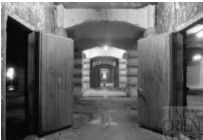
Figura 2 - Interior do Armazém Frigorífico.
