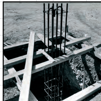
CONSTRUÇÃO DE UM PILAR DA F. CALOUSTE GULBIENKIAN, 1964
