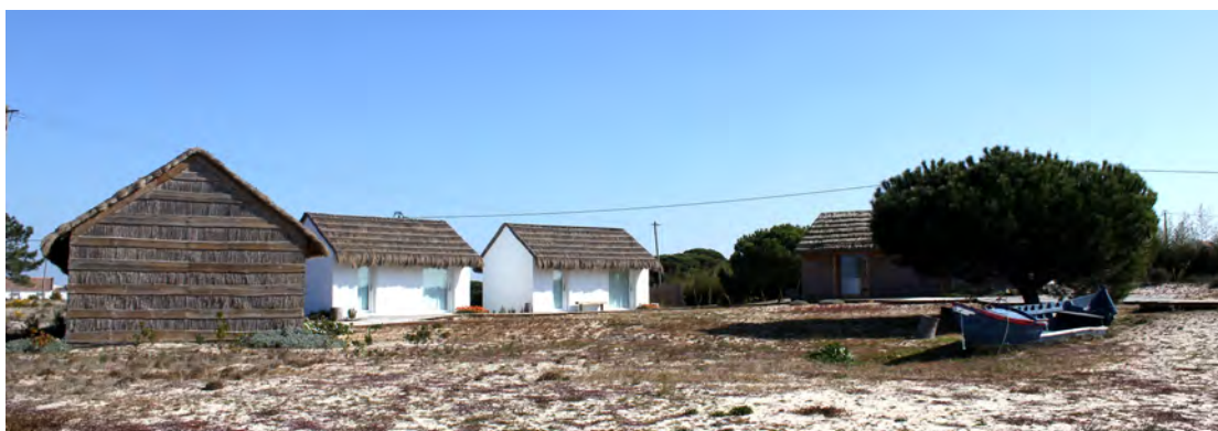
Ilustração 70 - “Areia, palha e madeira” - Casa na Comporta”. (Ilustração nossa, Comporta, 2012)
