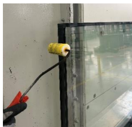
Figura 22 - Passagem do rolo para aperfeiçoar mastic .
