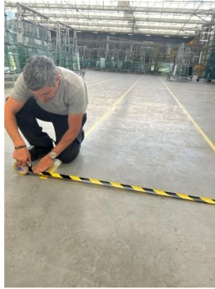
Figura 34 - Marcação do layout com fita.
