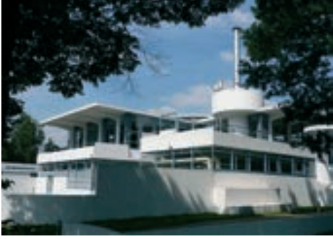
Ilustração 9 - Sanatório de Zonnerstraal após intervenção, s/d. ( http://commondatastorage.googleapis.com/static.panoramio.com/photos/original/3677908.jpg )
