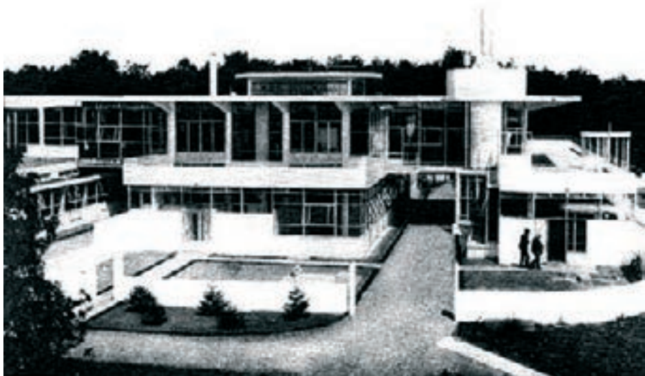
Ilustração 1 - Sanatório de Zonnestraal, Hilversum, Holanda, na primeira metade do séc. XX ( http://eng.archinform.net/projekte/1716.htm )
