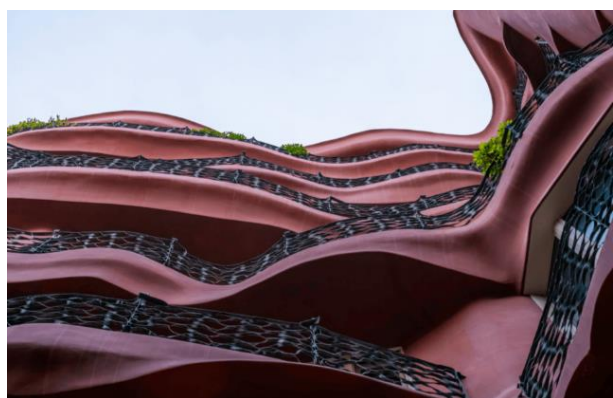
Figura 34 - Fachada (pátio interno) da La Pedrera, Antoni Gaudí, 1912, Barcelona, Espanha
