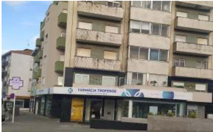
Figura 10: Fachada da Farmácia Trofense
