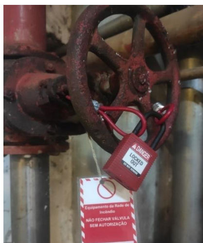
Figura 32 - Equipamento consignado localmente (Navigator Pulp Aveiro, 2023).
