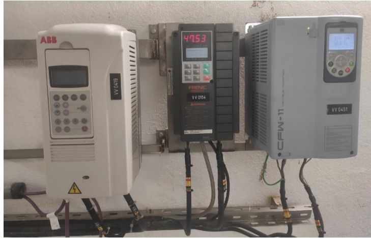
Figura 15 - Drives eletrónicas com variador (Navigator Pulp Aveiro, 2023).
