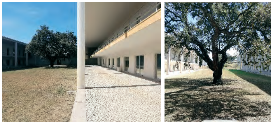
Visita á obra de arquitetura, escola superior de educação de Setúbal, do arquiteto Siza Vieira. (Fotografias elaboradas pela autora, 2023)
