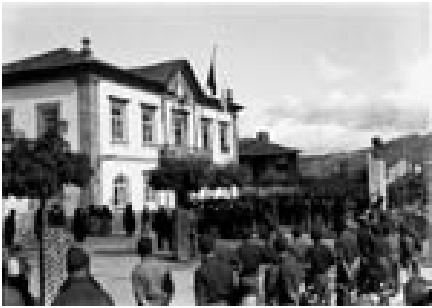
Fig. 62 - O edifício do Paços do Concelho
