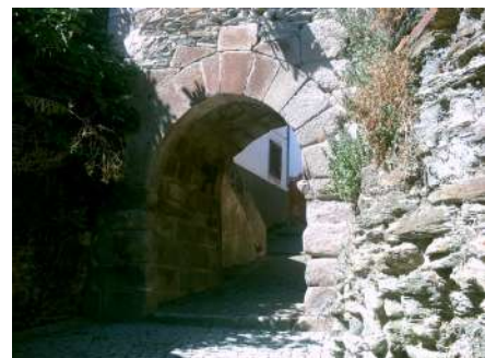
Fig. 25 - Fotografia do portal situado no lado nascente
