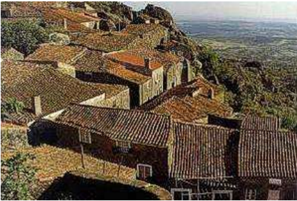
Fig. 49 - Tipos de coberturas predominantes e seus revestimentos
