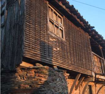
Fig. 55 - Sistema construtivo conhecido por tabique
