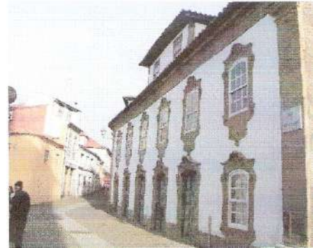
Fig. 101 - Solar dos Pimentéis
