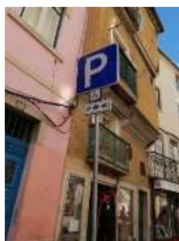
Ilustração 33 - Estado do Edificado (2/3). (Ilustração nossa, 2021).
