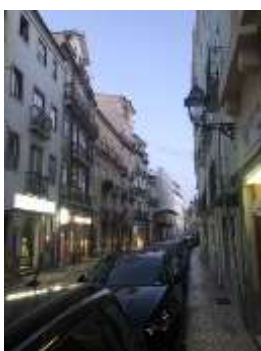
Ilustração 32 - Estado do Edificado (1/3). (Ilustração nossa, 2021).
