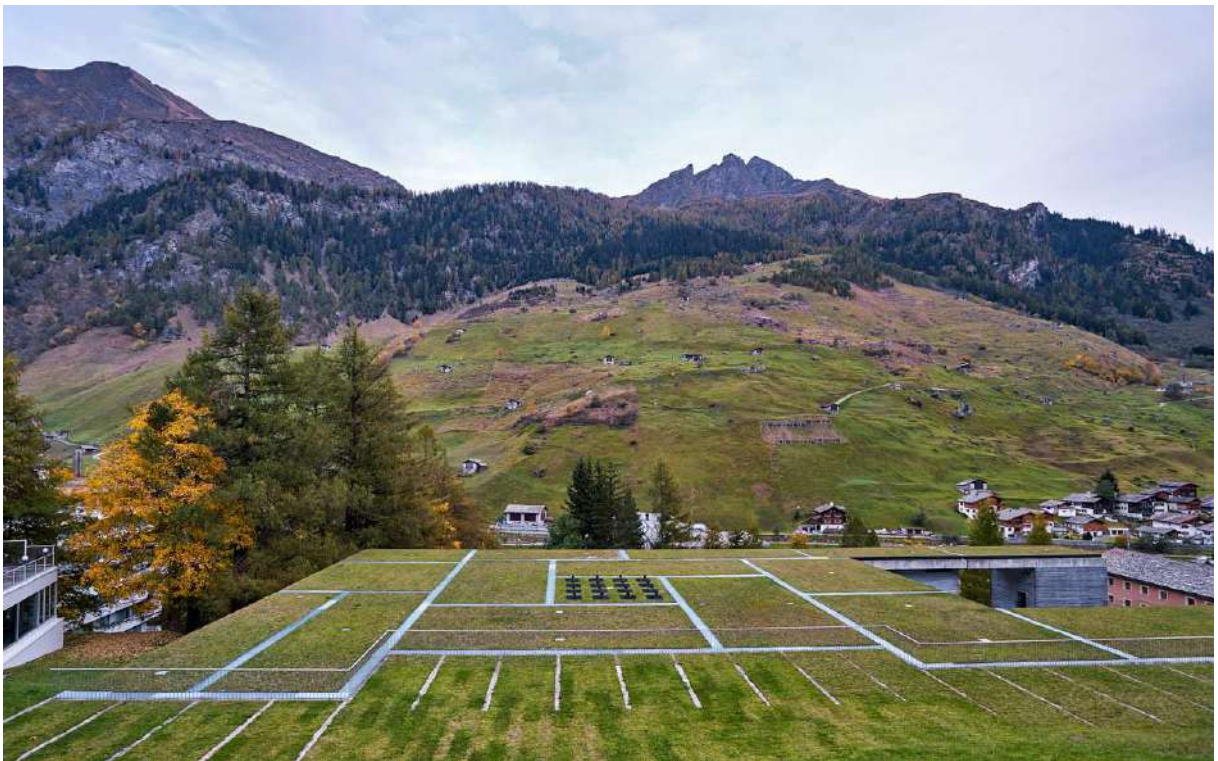
Figura 2.15: Vista da cobertura. Reproduzido de BLOCH, Jennifer, FRIEDMAN, Lee, [acedido a 31 de Agosto de 2021] disponível em http://www.soak-d.com/posts/2016/5/21/c7u5heolxqvulg0xy18ww8sv8tmt6t
