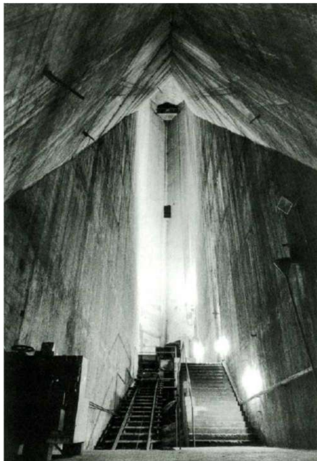
Figura 2.8: Interior da barragem de Albigna. Reproduzido de Zumthor, 2008:20.
