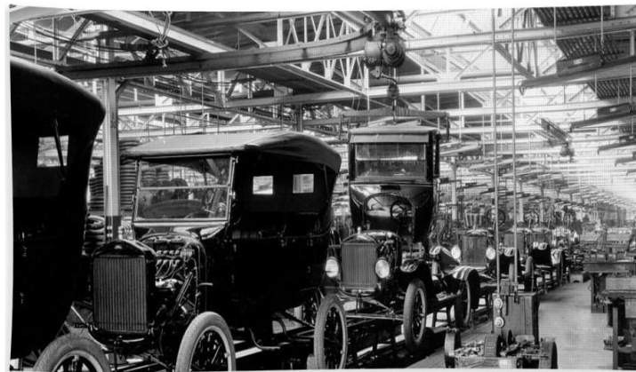
Figura 3 – Linha de montagem Ford Model T (Ford, n.d.).
