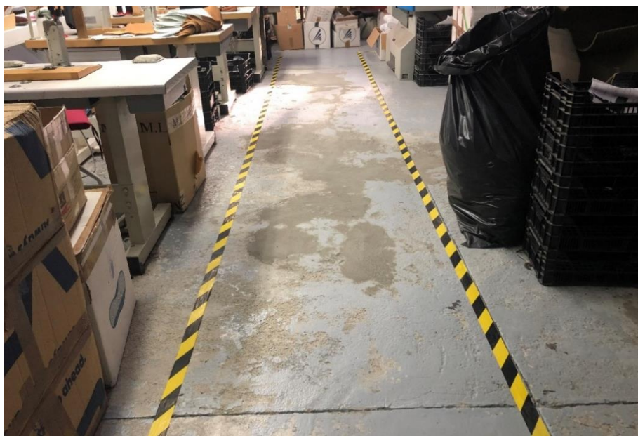
Figura 41 – Delimitação de caminhos de circulação
