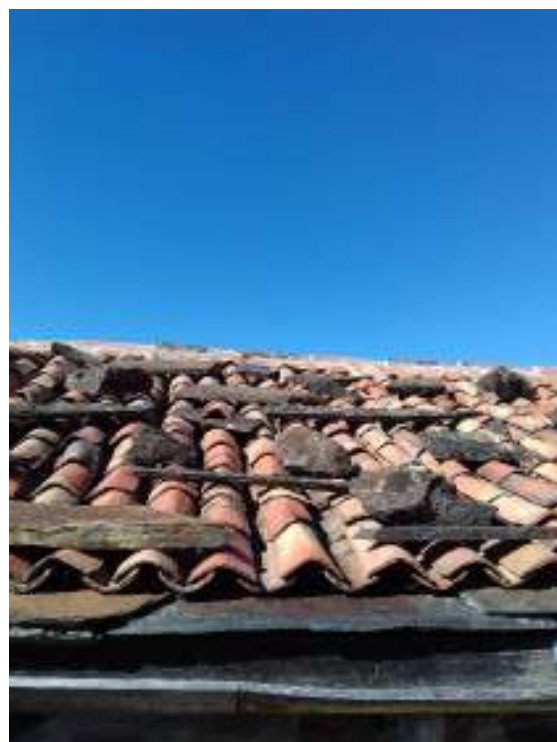
Fig. 56 Cobertura em telha canudo e lajetas de xisto
