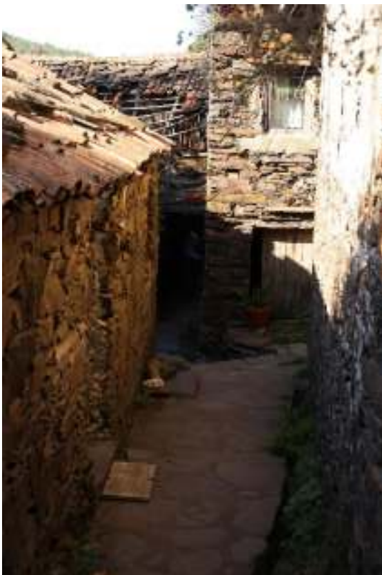
Fig. 40 Percurso em lajetas de xisto no interior da aldeia
