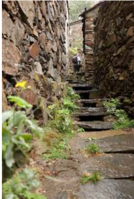
Fig. 39 Escadaria recorrendo ao uso de lajetas de xisto
