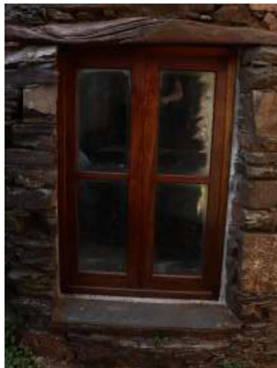
Fig. 58 Lintel e janela em madeira
