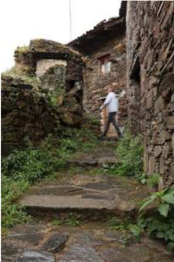
Fig. 38 Percurso pedonal do eixo principal da aldeia
