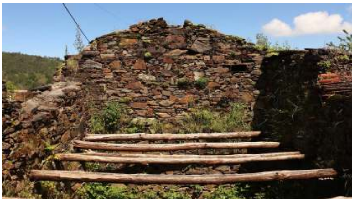
Fig. 59 Ruína ainda com as vigas de piso, que dividiam a habitação (piso superior) do curral (piso inferior)
