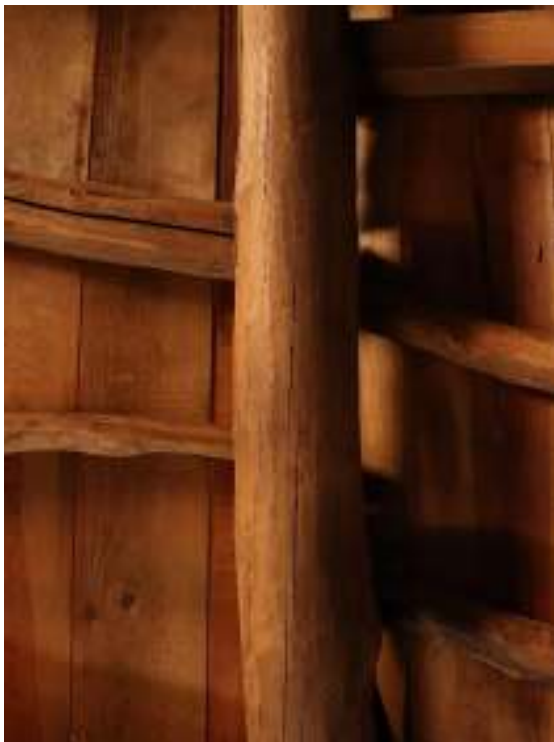
Fig. 55 Viga cumeeira, varas e forro de madeira
