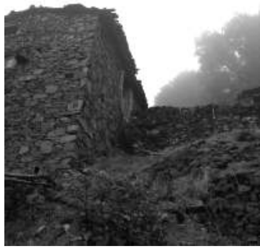
Fig. 5 Habitação num local acidentado (Catarredor, Lousã)
