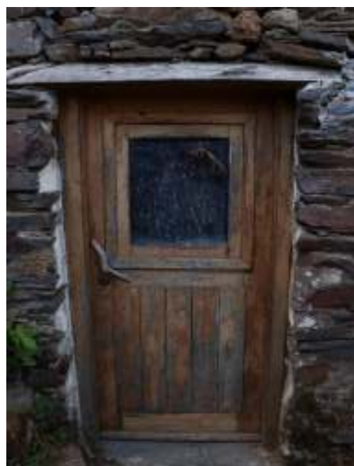
Fig. 54 Porta e lintel em madeira
