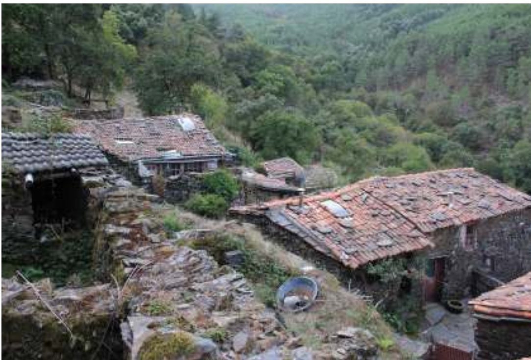
Figura 15 : Fotografia da adaptação das edificações da aldeia do Catarredor à Serra da Lousã
