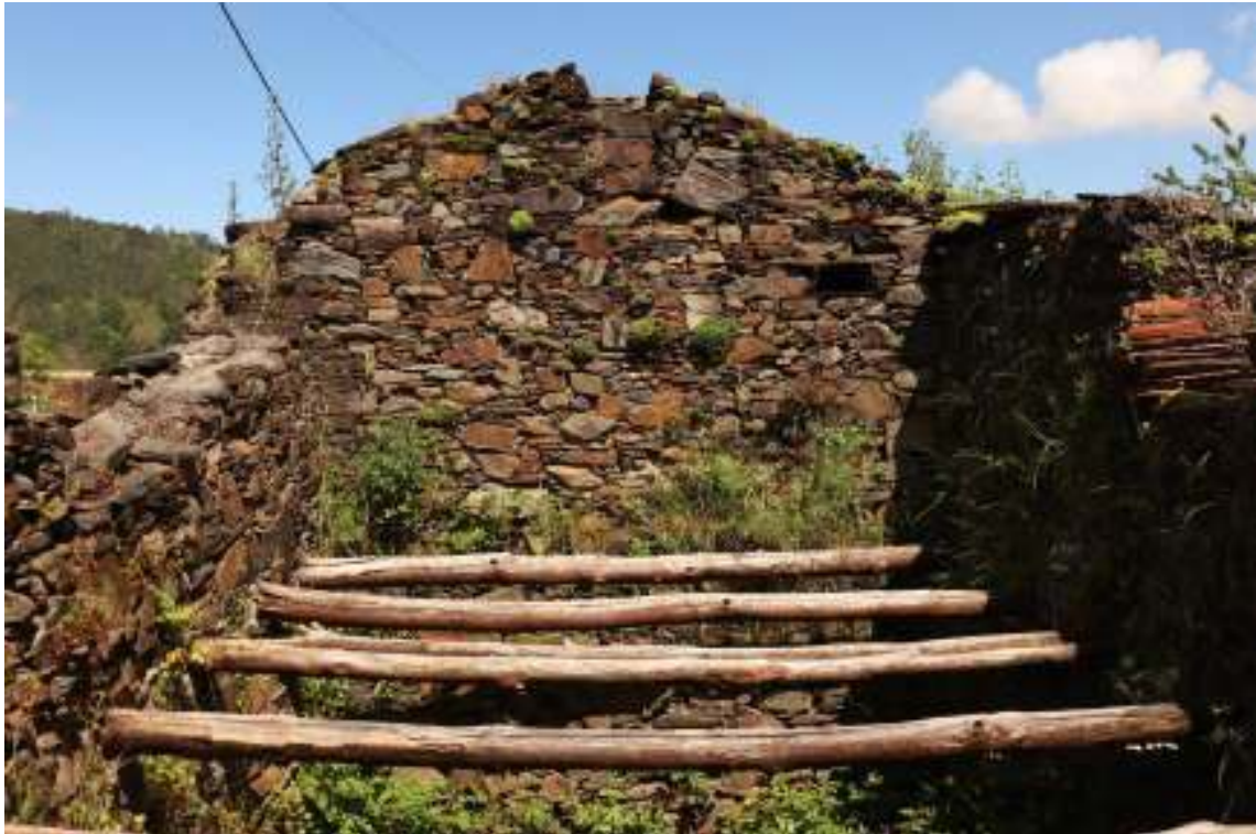
Figura 20 : Fotografia dos materiais mais utilizados nas edificações da aldeia do Catarredor
