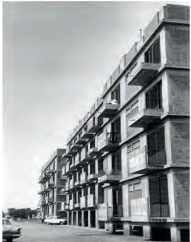
15. Edifício em fachada do Bairro dos CTT, Luanda, Angola. (2017) p. 110.
