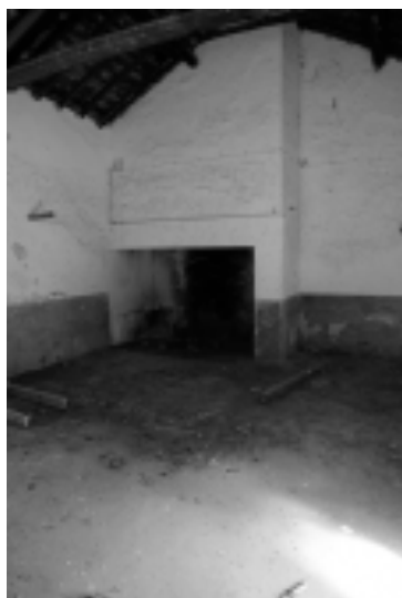
Ilustração 79 – Interior da casa dos operários, João Mendes Ribeiro, 2015. (cortesia do Arquiteto João Mendes Ribeiro, 2019)
