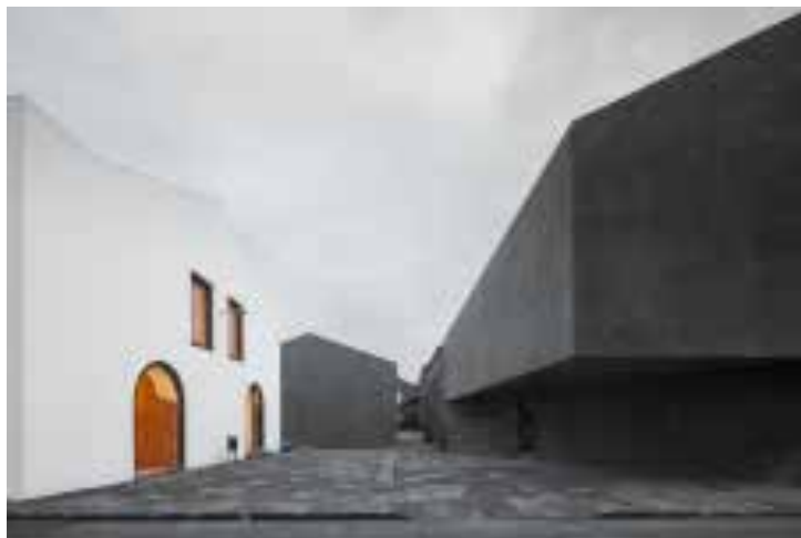
Ilustração 220 – Entrada Sul para o público do ACAC, José Campos, 2015. (cortesia do arquiteto João Mendes Ribeiro, 2019).
