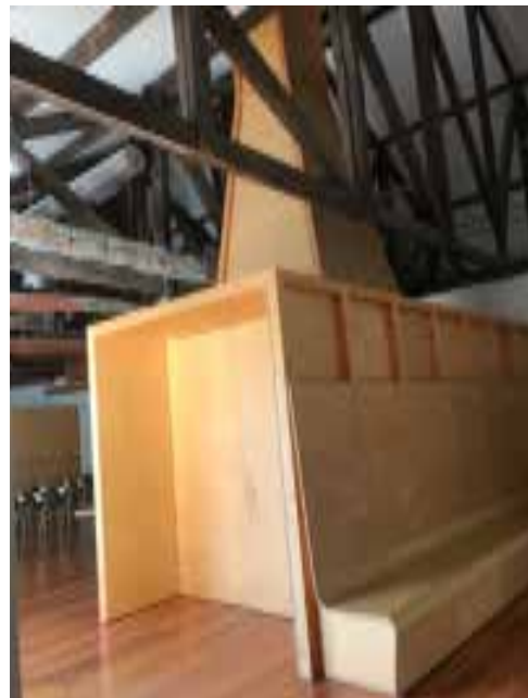
Ilustração 199 - Recriação do lanternim existente, num contentor solto insere a Instalação sanitária, Centro de Artes Visuais, Arquitetura, João Mendes Ribeiro, (Ilustração Nossa, 2019).
