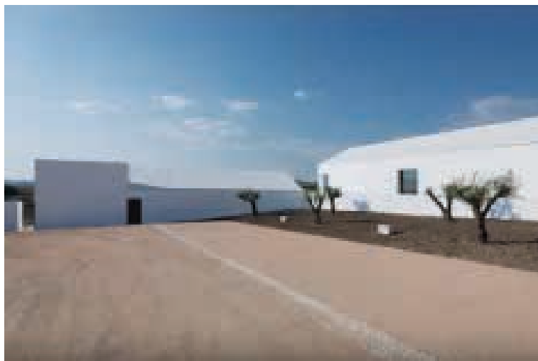
Ilustração 164 – articulação entre o muro do espelho de água e a habitação do caseiro. (Ribeiro, 2015, min. 19:24).
