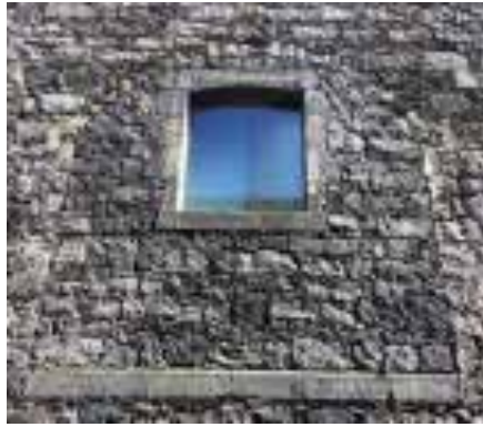
Ilustração 228 – Caixilho oculto pelo interior, vão preexistente visivelmente marcado. (Ilustração Nossa, 2017)
