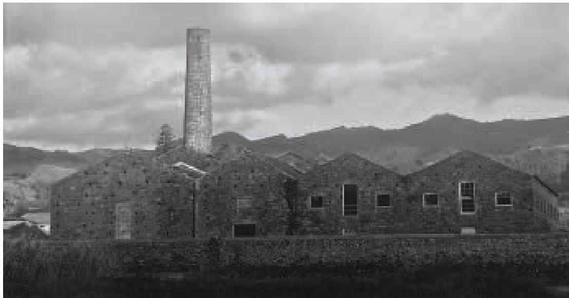
Ilustração 176 – Preexistência – Vista Geral, (cortesia do Arquiteto João Mendes Ribeiro, 2019).
