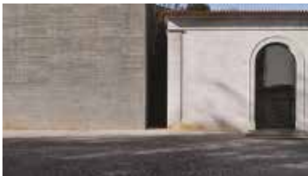
Ilustração 37 – A diferença de materialidades na distinção dos dois tempos. João Armando Ribeiro, 2008. ([Adaptado a partir de:]cortesia do Arquiteto João Mendes Ribeiro, 2019).
