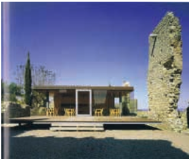
Ilustração 200 - Casa de Chá, nesta intervenção o arquiteto recuou os pilares, de modo a ocultar os apoios da estrutura dando a ideia de levitação, adquirindo um caráter inócuo, Édgar Martins. (Pedro, 2011, p. 27).
