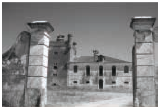
Ilustração 73 – Portão Principal da Herdade, antes da intervenção, João Mendes Ribeiro, 2015. (cortesia do Arquiteto João Mendes Ribeiro, 2019).
