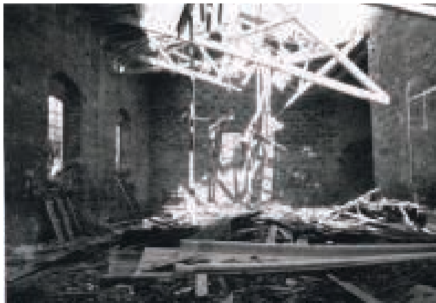
Ilustração 185 – Vista Interior da preexistência. (cortesia do Arquiteto João Mendes Ribeiro, 2019).
