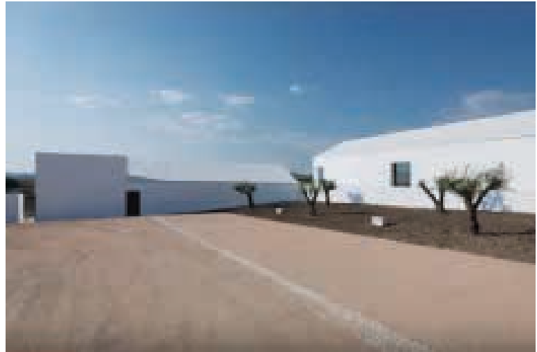
Ilustração 164 – articulação entre o muro do espelho de água e a habitação do caseiro. (Ribeiro, 2015, min. 19:24).
