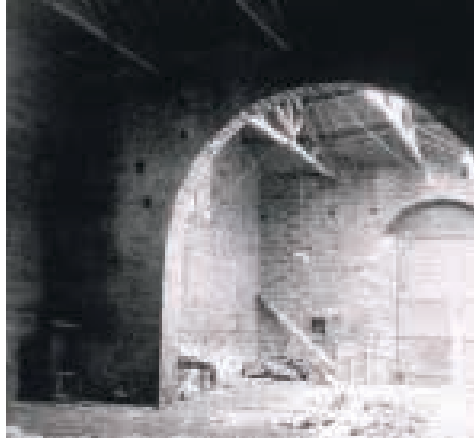
Ilustração 184 – Vista interior da preexistência. (cortesia do Arquiteto João Mendes Ribeiro, 2019).
