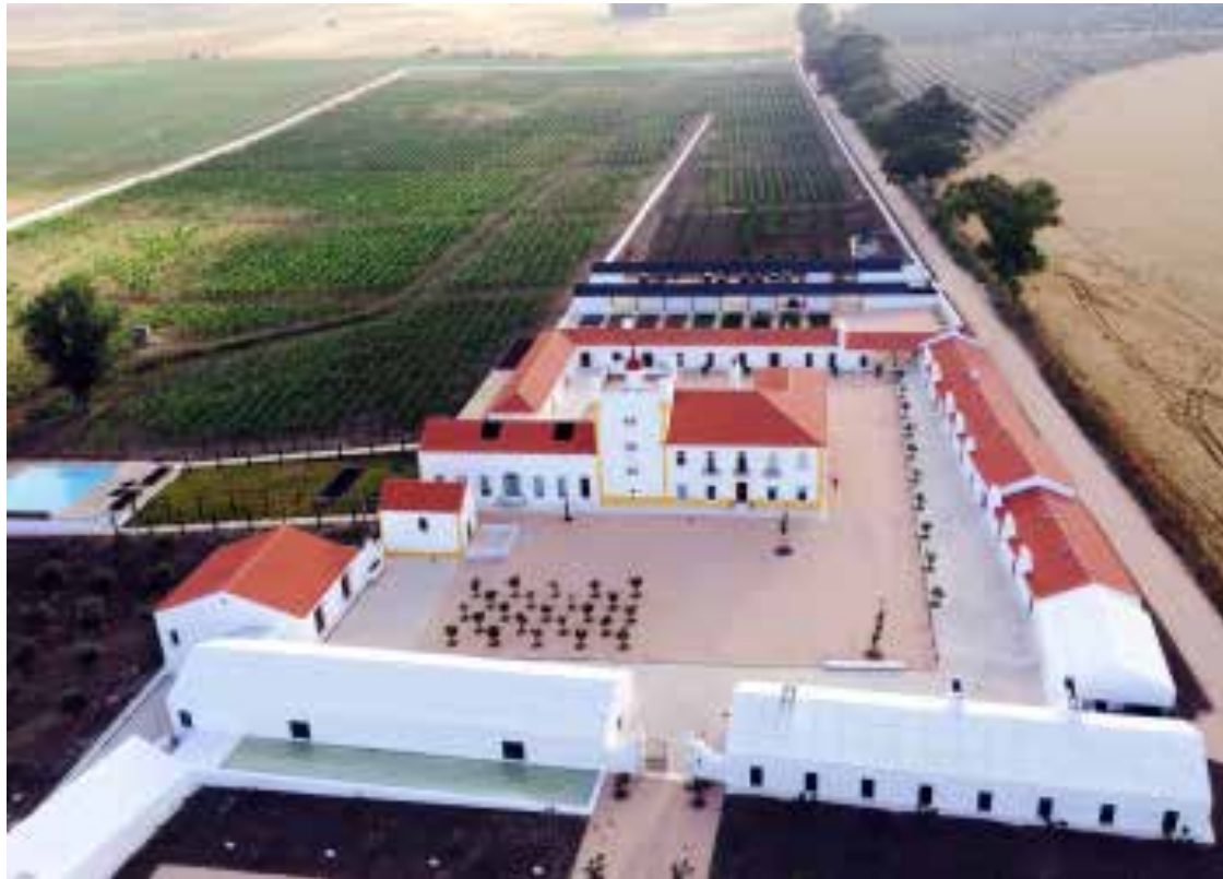
Ilustração 107 - Vista Geral sobre a Herdade de Torre de Palma, (cortesia do Arquiteto João Mendes Ribeiro, 2019).
