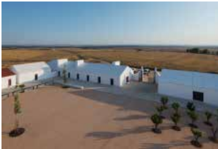
Ilustração 155 – os novos edifícios com a cobertura ventilada, em lajetas de betão branco, (Ribeiro, 2015, min. 16:19)
