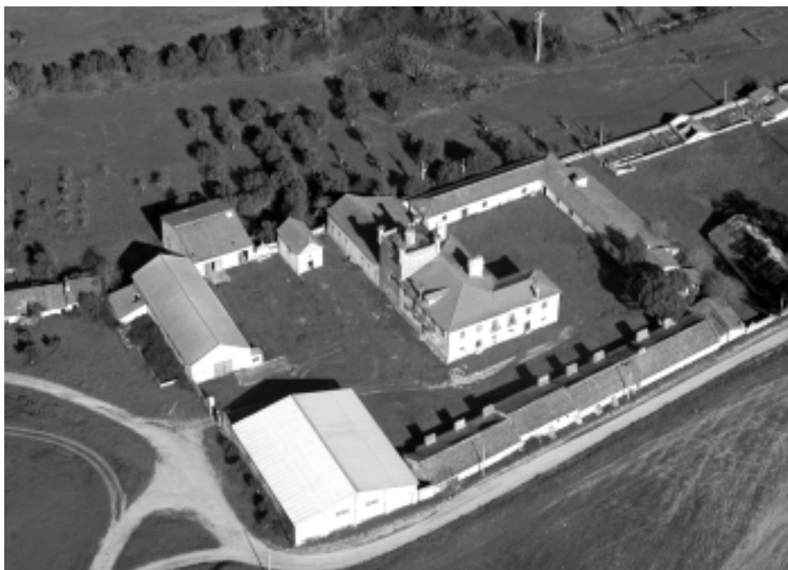
Ilustração 81 – Vista Geral de toda a Herdade de Torre de Palma, antes da intervenção, João Mendes Ribeiro, 2015. (cortesia do Arquiteto João Mendes Ribeiro, 2019).
