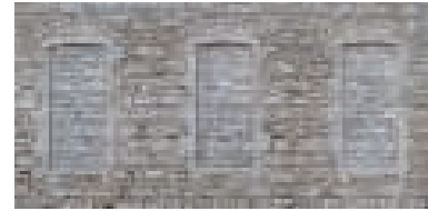
Ilustração 230 – Vãos preexistentes, que foram fechados. (Ribeiro, 2015, min.36:12)
