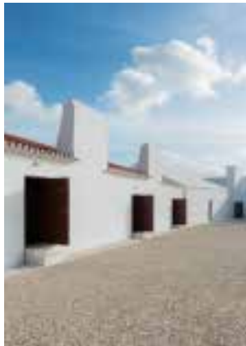
Ilustração 151 – manutenção da cal tradicional e das portas de madeira, colocando no interior portas de vidro. do mal o menos, Eduardo Nascimento e João Fôja, 2014. (cortesia do Arquiteto João Mendes Ribeiro, 2019)
