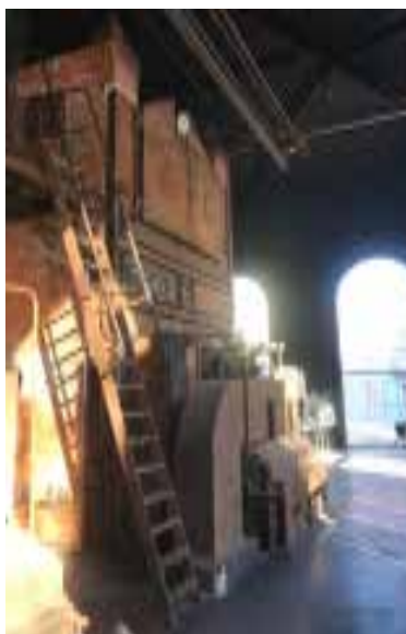
Ilustração 39 – Espaço interior da Casa das Caldeiras. (Ilustração Nossa, 2019)
