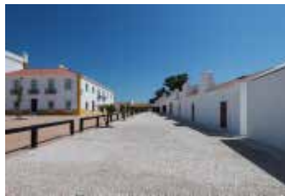
Ilustração 138 – Zona exterior das suites, do mal o menos, Eduardo Nascimento e João Fôja, 2014.(cortesia do Arquiteto João Mendes Ribeiro, 2019)
