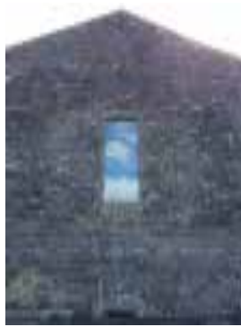
Ilustração 229 – Caixilho oculto pelo interior, vão preexistente visivelmente marcado. (Ilustração Nossa, 2017)
