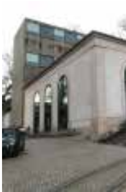
Ilustração 101 – Fachada, da Casa das Caldeiras, (Ilustração Nossa, 2019)
