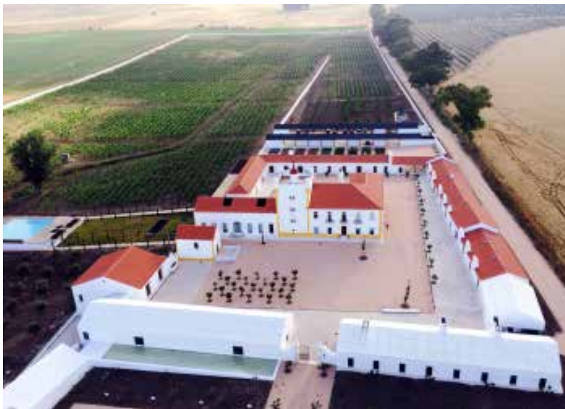
Ilustração 107 - Vista Geral sobre a Herdade de Torre de Palma, (cortesia do Arquiteto João Mendes Ribeiro, 2019).
