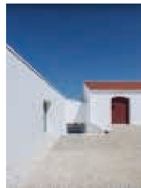
Ilustração 162 – Relação entre o edifício novo da adega e o preexistente de apoio (Ribeiro, 2015, min. 18:57)
