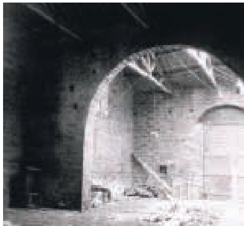
Ilustração 184 – Vista interior da preexistência. (cortesia do Arquiteto João Mendes Ribeiro, 2019).
