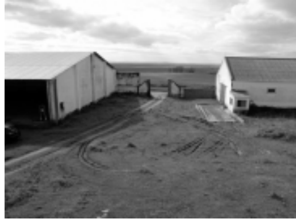
Ilustração 76 - Antigos armazéns no interior do terreiro, João Mendes Ribeiro, 2015. (cortesia do Arquiteto João Mendes Ribeiro, 2019).
