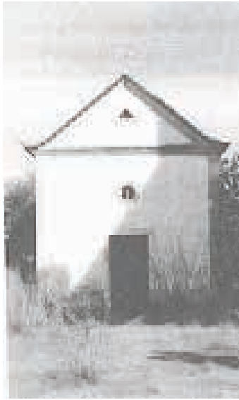
Ilustração 70 – Capela, em estado de abandono. (Câmara Municipal de Monforte, 2014, p. 172).
