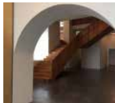
Ilustração 213 – detalhe das escadas, elemento solto, ACAC, (Ilustração Nossa, 2018).
