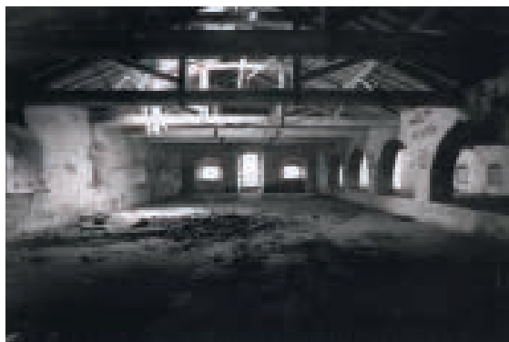
Ilustração 186 -Vista interior da preexistência. (cortesia do Arquiteto João Mendes Ribeiro, 2019).
