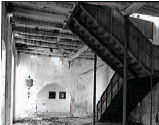
Ilustração 182 – Vista interior, escadas preexistentes.(cortesia do Arquitecto João Mendes Ribeiro, 2019).
