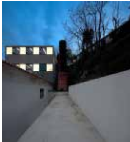
Ilustração 59 - Prolongamento do muro de suporte da rua, Fernando Guerra, FG+SG, 2008. ([Adaptado a partir de:] Basulto, 2010).
