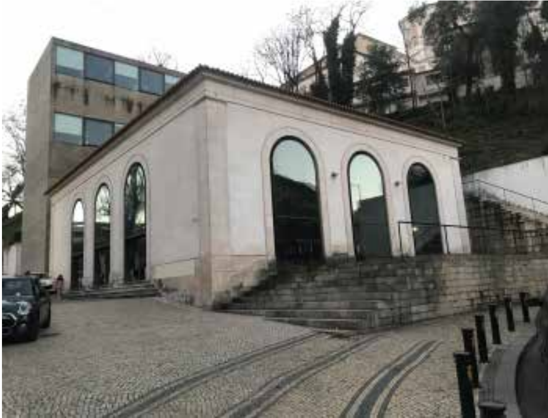
Ilustração 36 – Vista geral do Edifício da Casa das Caldeiras, (Ilustração Nossa, 2019)
