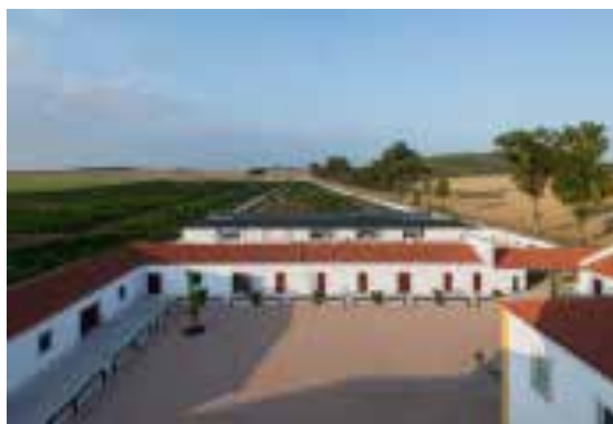
Ilustração 137 – Vista da Torre, lado norte, do mal o menos, Eduardo Nascimento e João Fôja, 2014.(cortesia do Arquiteto João Mendes Ribeiro, 2019)
