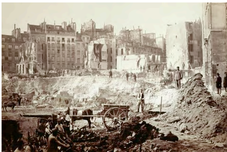
Ilustração 2 - Destruição de Paris durante a implementação dos planos de Haussman. (Combis, 2019).
