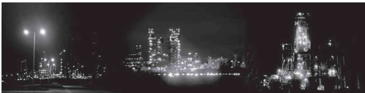
03_EMN-3_refinaria petrogal_leça da palmeira
